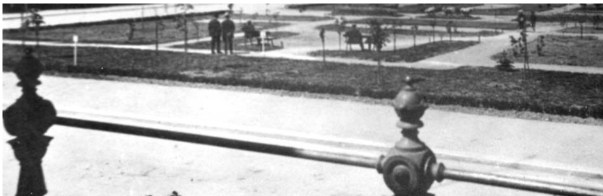
Detalj av räcket efter trappans tillkomst 1903 vid Tingshusets västra sida.
