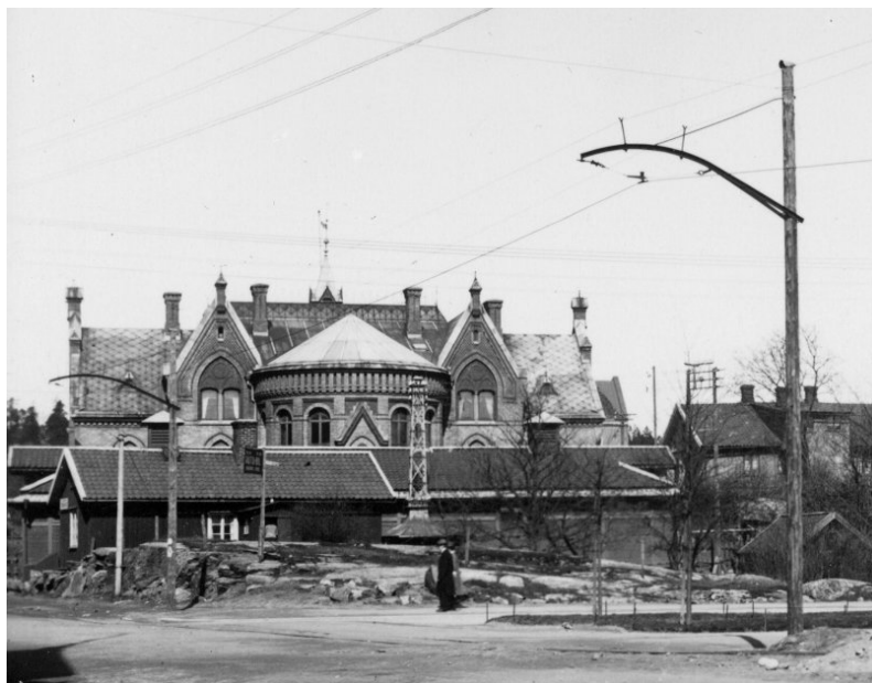
Tingshuset från öster ca 1910. Framför Tingshuset i bild syns bl a stallet för nämndemännens hästar och "transformatorhuset".
