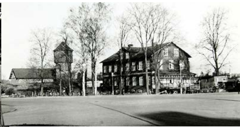
Järnvägshotellet & vattentornet sett från Bangårdsgatan, 1952
