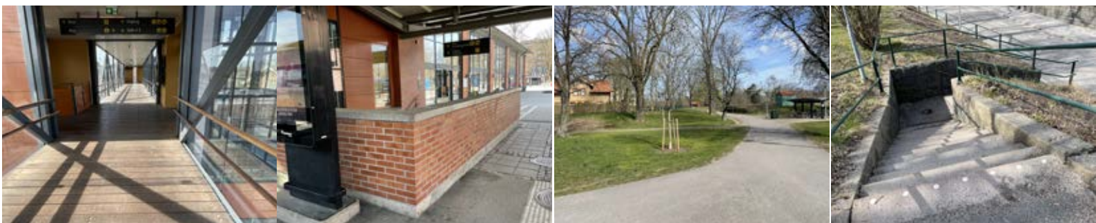
1. Gångbro över järnväg
