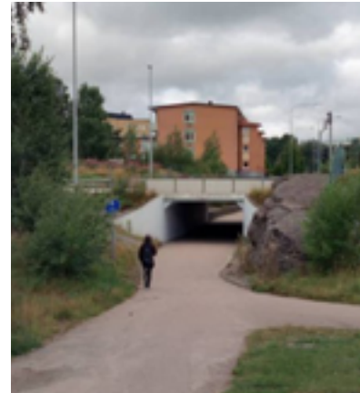
GC-tunnel under E45 i norra Slättervägens förlängning.
