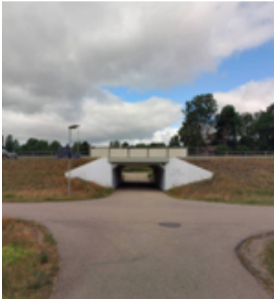
GC-tunnel under E45 i norra Lextorp.
