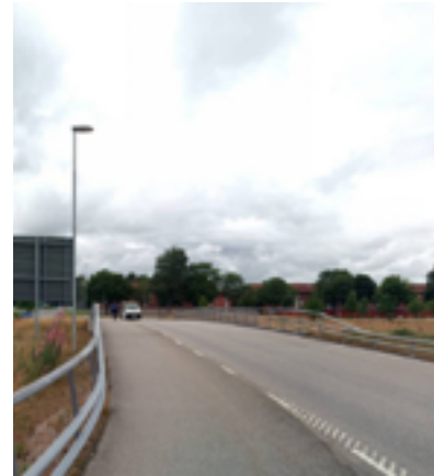
Koppling över E45 i södra Lextorp vid Lextorpsvägen.
