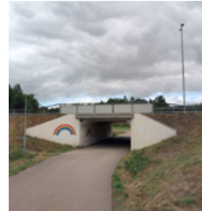
GC-tunnel under E45 i Lextorp i Lantmannavägens förlängning.
