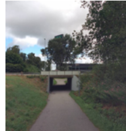
GC-tunnel under Gärdhemsvägen vid Gärdhemsrondellen.
