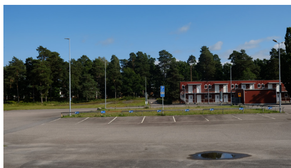
Asfalterad yta vid studentbostäderna.
