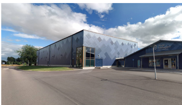
Idrottshall och fritidsgård, vy från väster.
