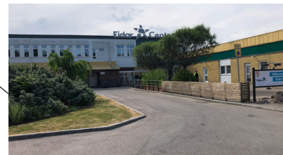
Ytan framför entrén till Eidar center har en otydlig användning och gör att entréerna till verksamheterna döljs. Detta förstärks med staket.
