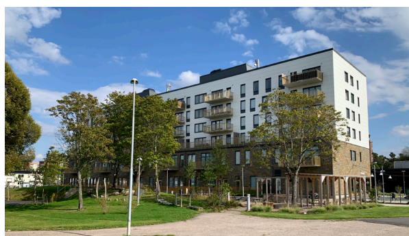
Skivhuset Hackan, fasad åt nordväst.
