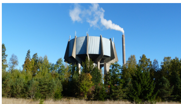
Vattentornet och värmeverkets skorsten.
