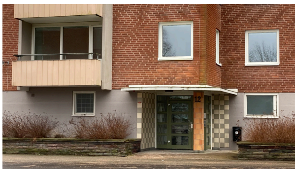
Indragen balkong och entré.
