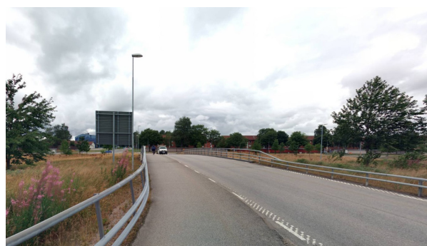
Kronogårdsporten mellan Karlstorp och Kronogården (1), gång- och cykeltunnel mellan Lextorp och Kronogården (2), samt bro med gång- och cykelväg mellan Lextorp och Sylte (3).
