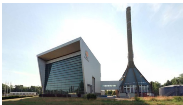
Fjärrvärmeanläggningen och skorstenen.
