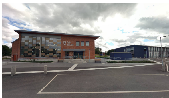
Bibliotek och skolbyggnad.
