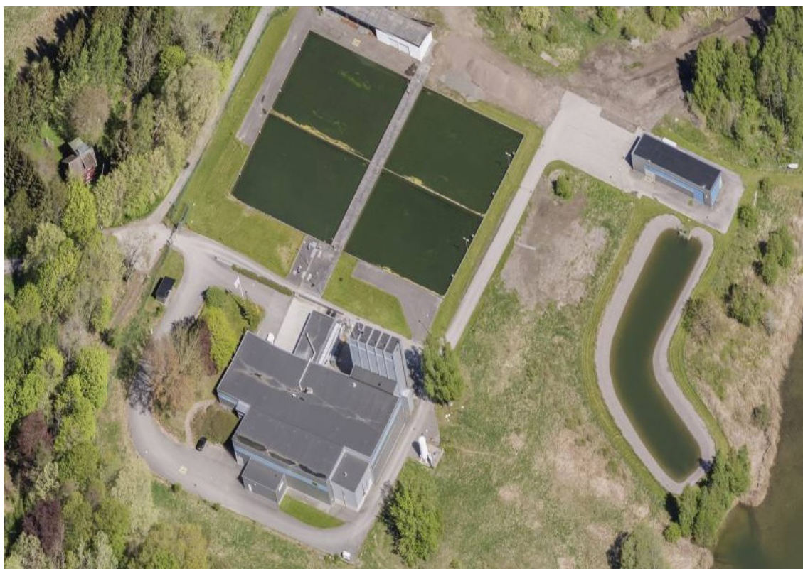
Flygbild över befintligt vattenverk, Trollhättans kommun 2020.
