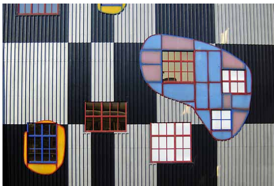
Konst på delar av fasad bryter av monotona fasader
