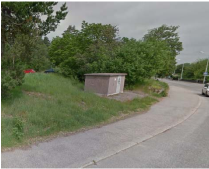
Transformator invid Nysätersvägen
