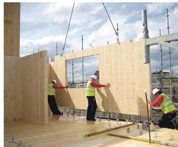
Uppförande av byggnad i massivträ
