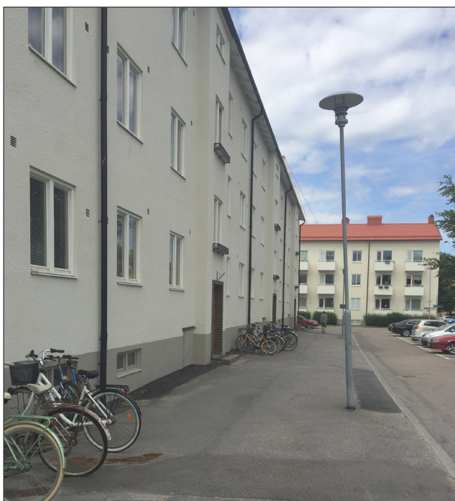
Befintligt bostadshus med förgårdsmark, Kv Lodjuret.
