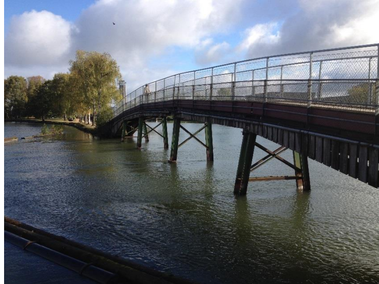
Figur 2 – Foto på bron, från södra landfästet och norrut. 2014-09-25.
