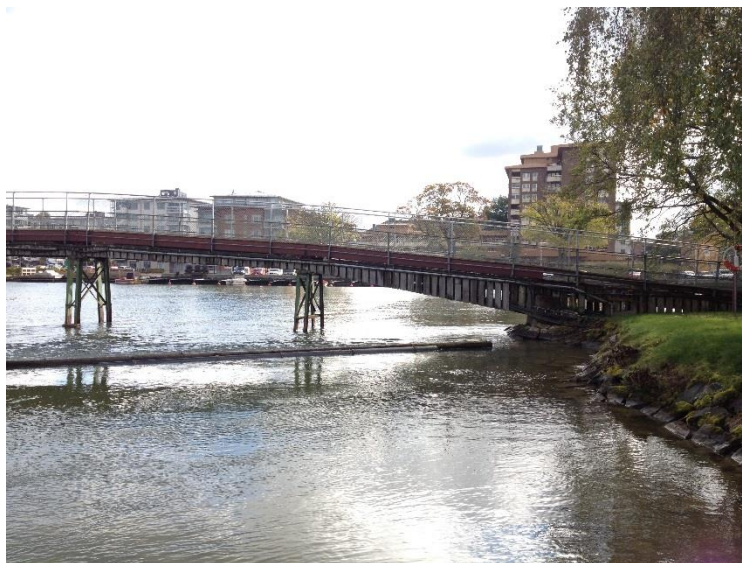
Figur 4 – Foto på bron, från väster och mot södra landfästet. 2014-09-25.
