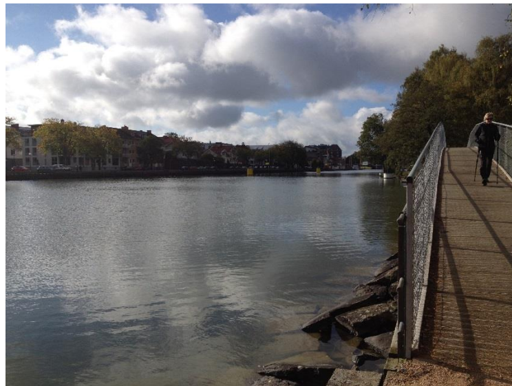
Figur 3 – Foto på bron, från norra landfästet och söderut. 2014-09-25.
