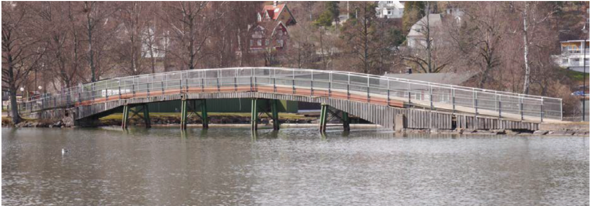
Figur 3. Befintlig bro från nordost.
