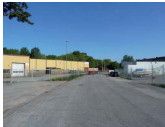
Faktorsgatan. Foto WSP Samhällsbyggnad
