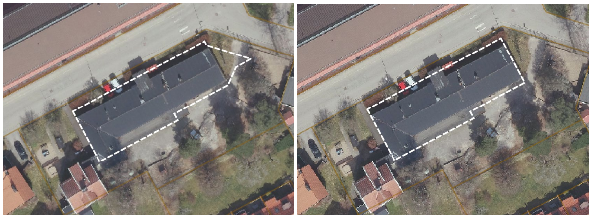
Bild 33-34. Ortofoto från 2022 som visar den nu rivna förskolebyggnaden. Till vänster visas hur förskolebyggnaden förhåller sig till den nya byggrätten. Till höger visas hur en byggnadsarea på 600 kvadratmeter inom byggrätten förhåller sig till förskolebyggnaden.
