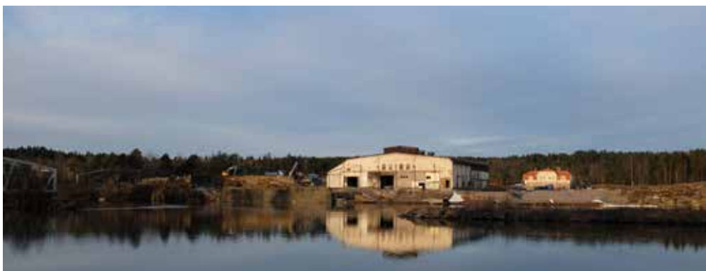
Vy mot Göta Älv och Stridsbergsområdet från Hjulksvarvel, efter rivningar 2019.
