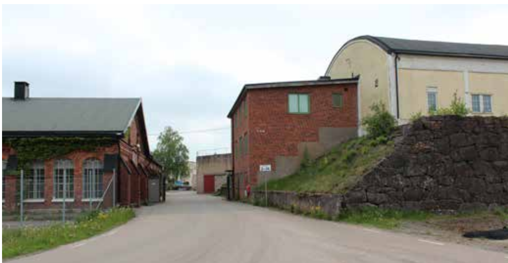
Entrén till Stridsbergsområdet, filfabriken till vänster och hyveljärnsfabriken till höger i bilden. Endast den del av hyveljärnsfabriken (gula byggnaden) som syns på bilden finns kvar efter rivning 2019.
