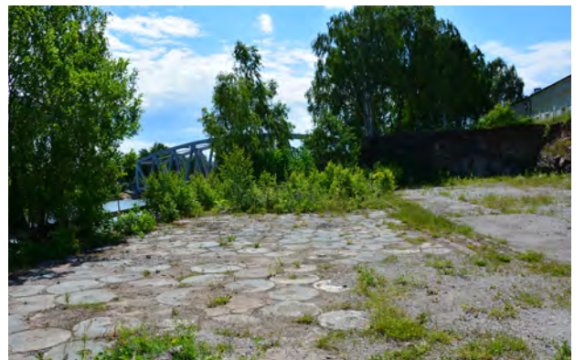
7. Plats med slipstenar som markbeläggning, en platå mot Göta älv. Järnvägsbron i bakgrunden.
