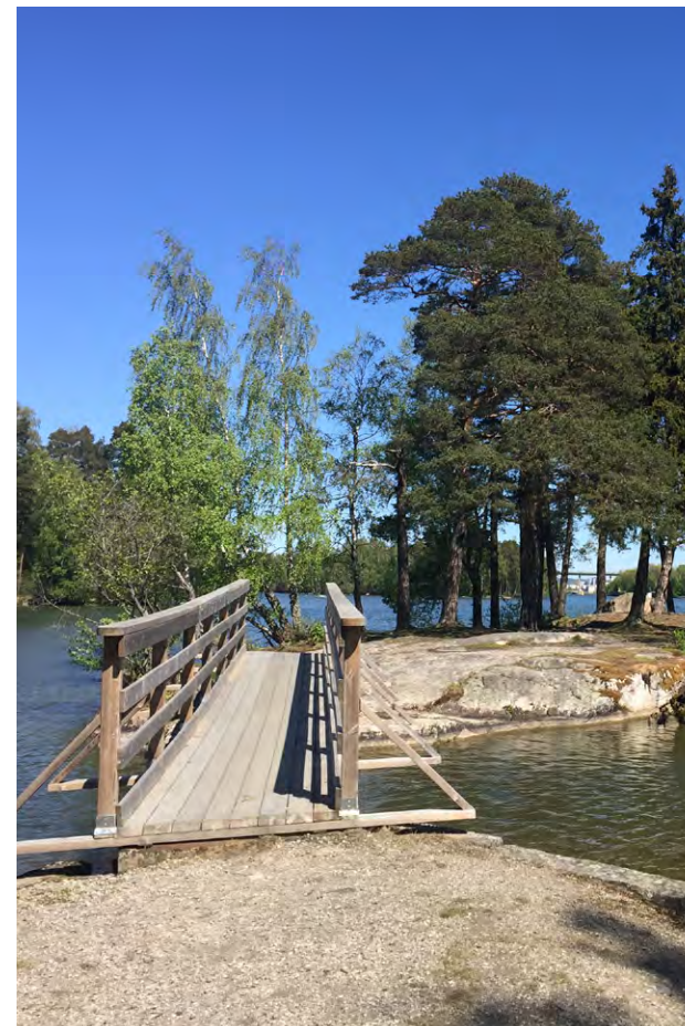
Befintlig bro ut till en liten ö
