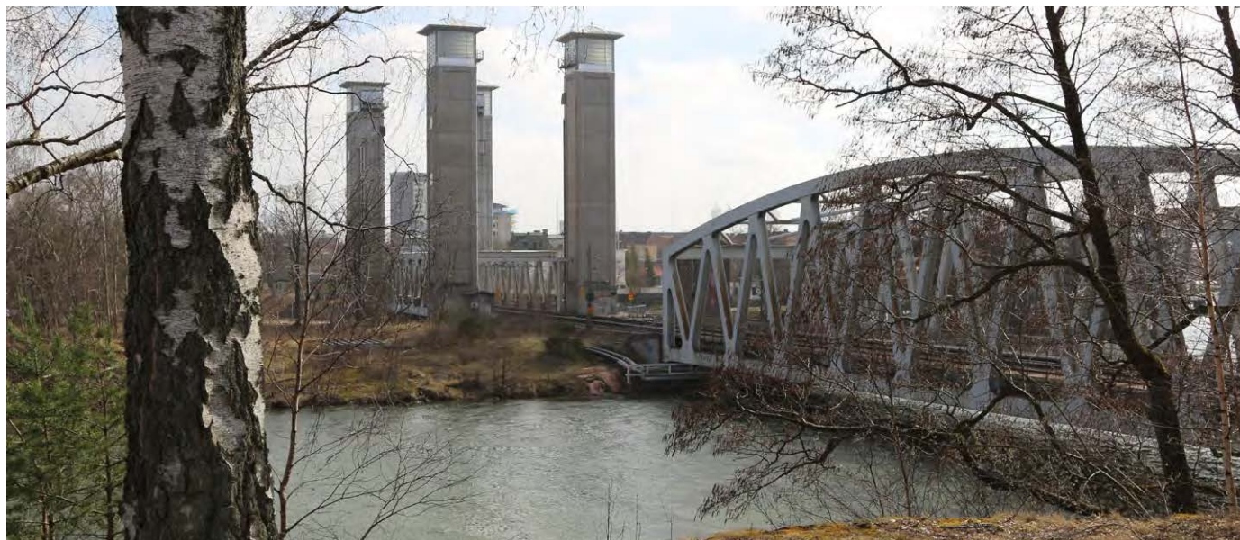
Bild på befintlig järnvägsbro över älven.
