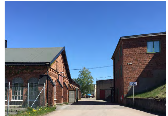
Entrén till området västerifrån med filfabriken till vänster i bild.
