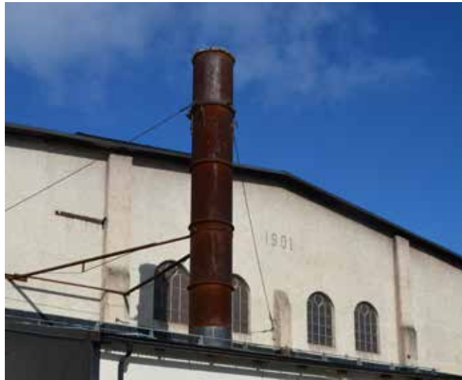
Martinverkets karaktäristiska fasad mot älven.
