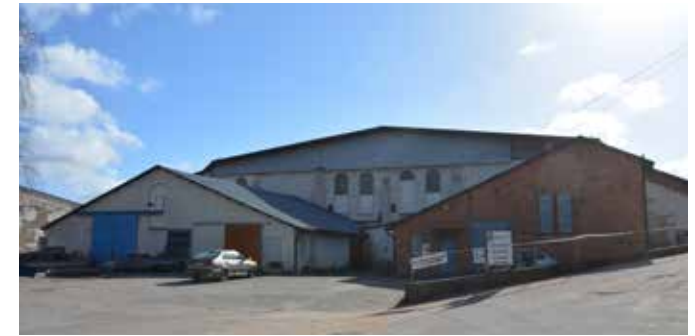
Martinverket med tillbyggnader (nu rivna).
