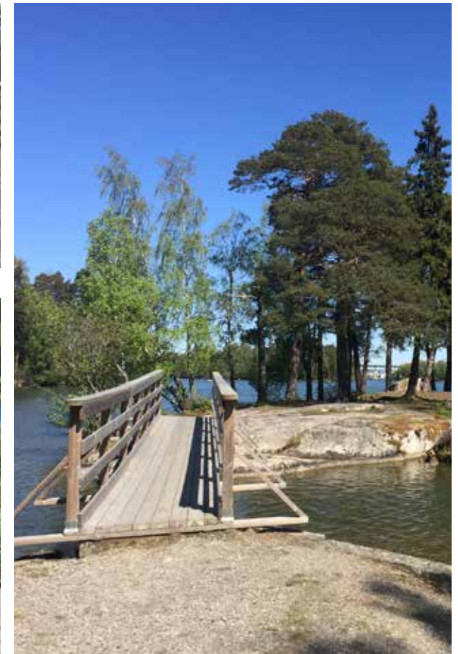
Befintlig bro ut till en liten ö
