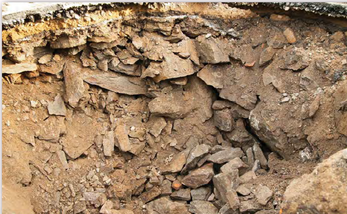
Figur B2:2 Exempel på grovt fyllnadsmaterial i provgrop PG 1214.
