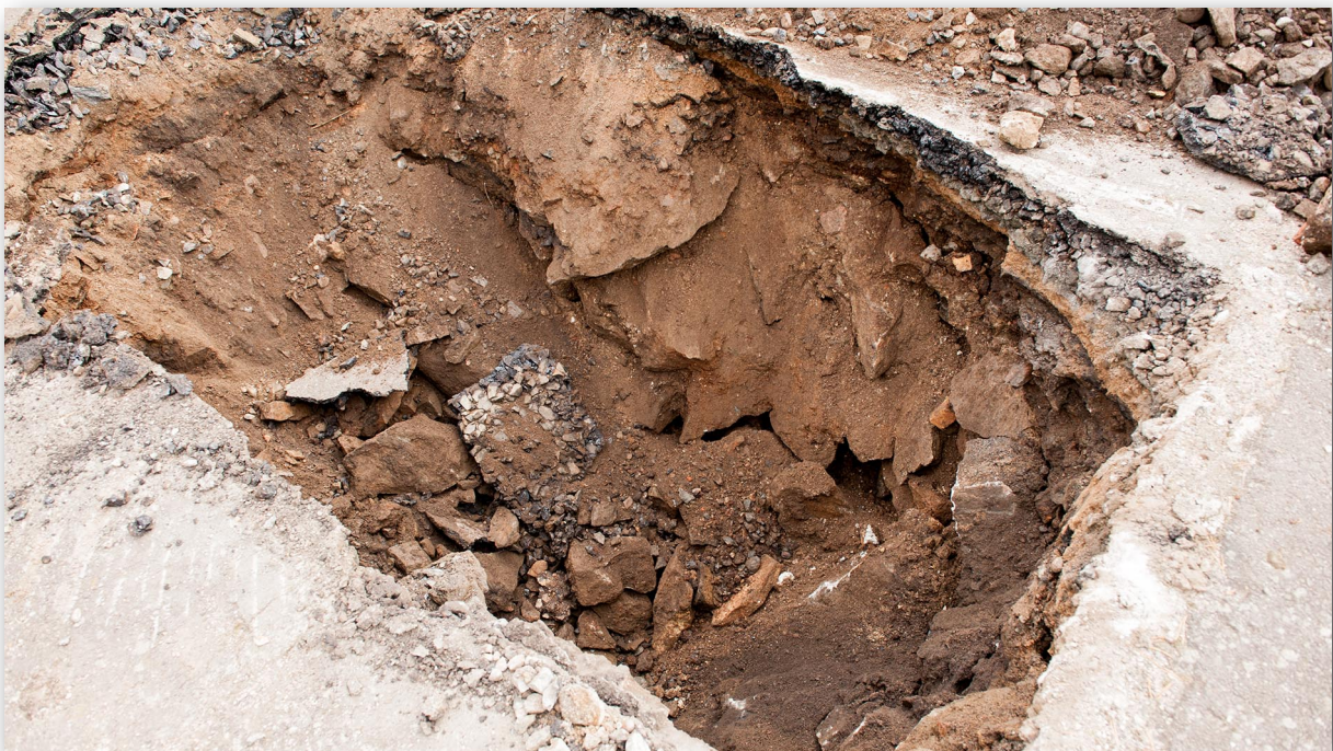
Figur 2. Pg 1508. Notera hålrum mellan större block.
