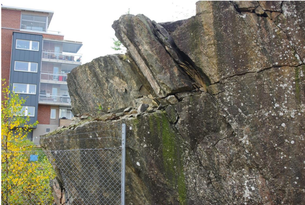
Figur 6: Lösa block i nordöstra hörnet på område 1. Foto taget mot syd.
