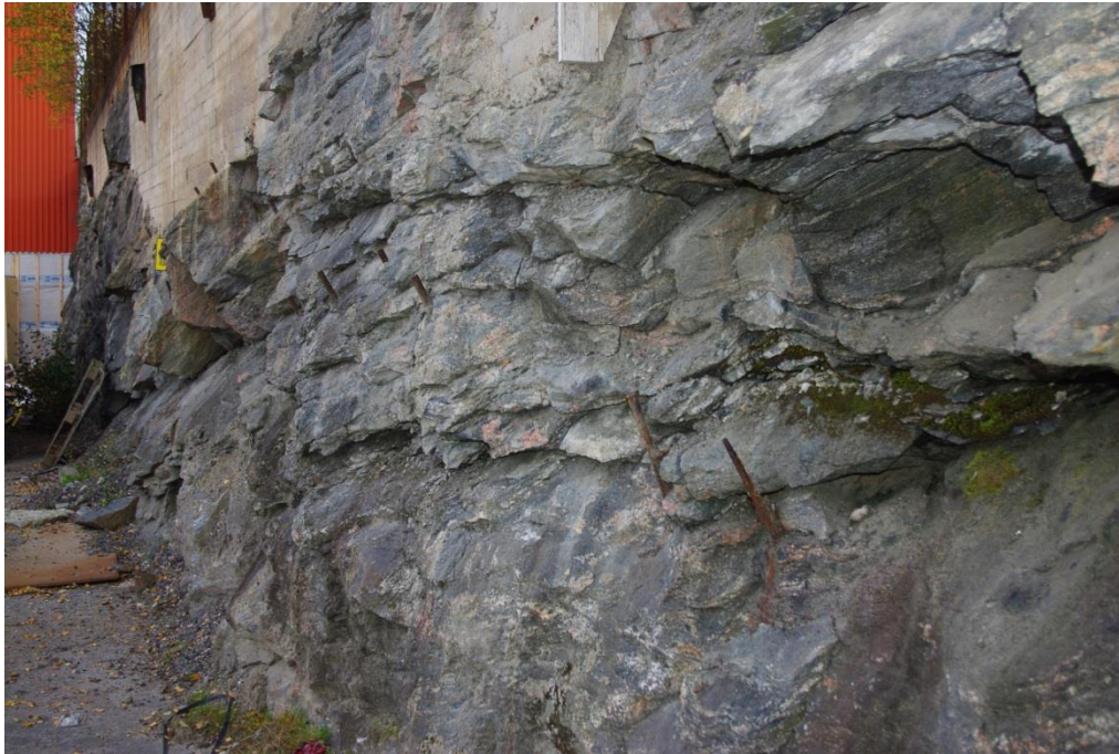
Figur 11: Foto visar subvertikala bultar i skärningen under muren i område 3. Foto taget mot ost-nordost.
