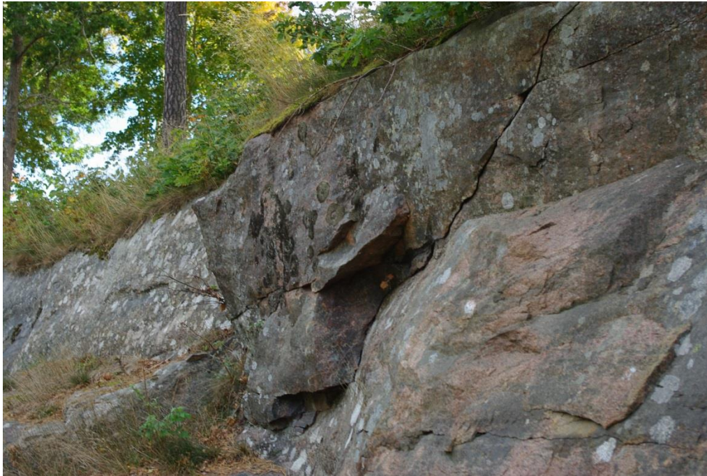
Figur 13: Foto över ett block som riskerar att glida ut vid promenadstråket intill älven Olidan. Foto taget mot öst.
