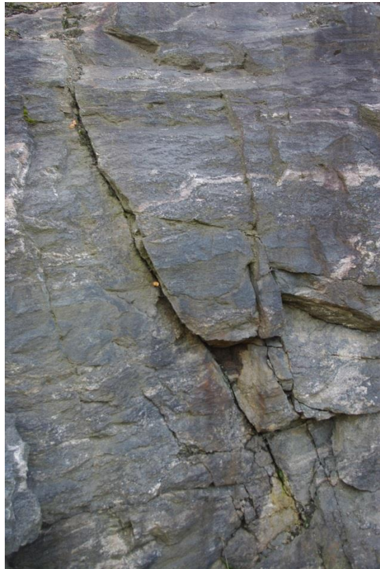
Figur 7 och 8: Figur 7 (vänster) visar block som riskerar att glida ut då skärningen lagts efter olika plan i samma sprickgrupp. Foto taget mot ost-nordost. Figur 8 (höger) visar en bergkil som bildats av sprickgrupperna i området, denna riskerar också att glida ut. Foto taget mot öst.
