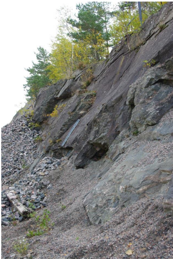
Figur 7 och 8: Figur 7 (vänster) visar block som riskerar att glida ut då skärningen lagts efter olika plan i samma sprickgrupp. Foto taget mot ost-nordost. Figur 8 (höger) visar en bergkil som bildats av sprickgrupperna i området, denna riskerar också att glida ut. Foto taget mot öst.
