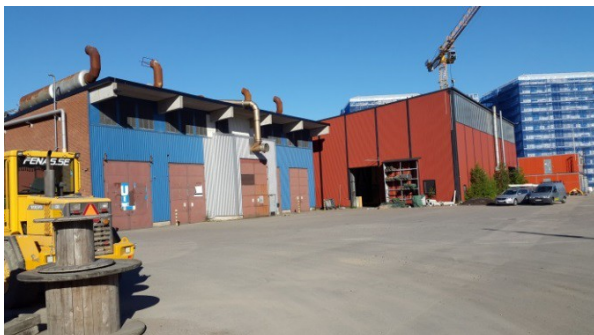
Byggnaderna 30 och 84 i söder. I fonden syns bygget av punkthusen i väster.
