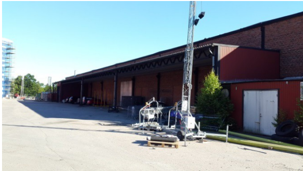
Hårdgjorda upplagsytor mellan industribyggnaderna dominerar den plana marken åt väster.
