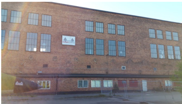
Den högre delen av byggnad 79 mot Åkerssjövägen med en långsmal utbyggnad i bottenvåningen
