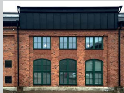
Plåttak, hänggrännor och stuprör fabr. Lindab, kulör 015 Svart
