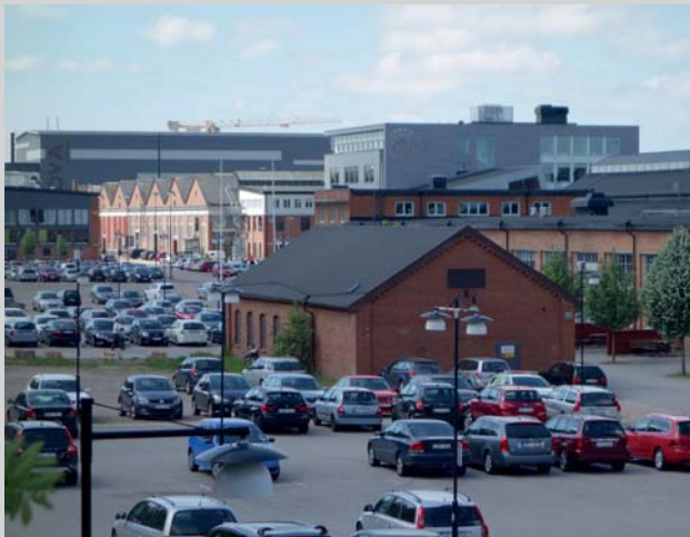
Stora hårdgjorda parkeringsytor dominerar området och bidrar till storskaligheten
