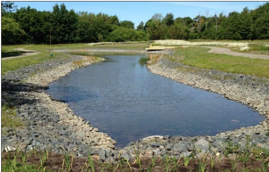
Figur 15. Exempel på dagvattendamm i Trönninge i Varberg (Foto: Norconsult).
