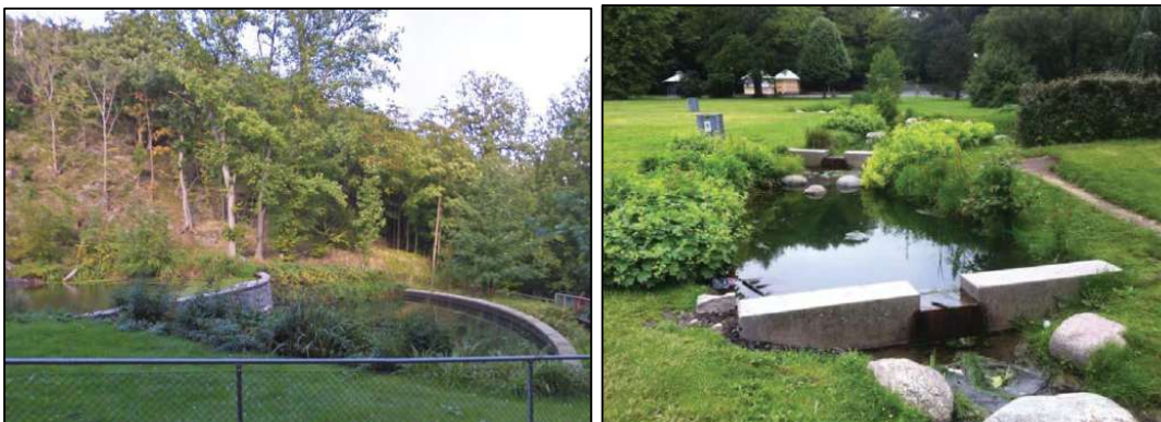
Figur 18. Fördröjande dagvattendiken/kanaler i Slottsskogen, Göteborg.
