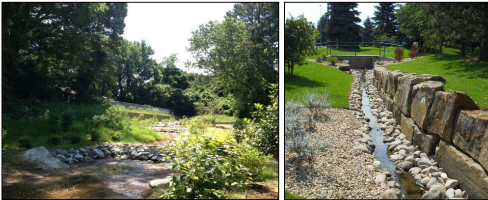
Figur 17. Fördröjande dagvattendike (James City county 1 ) och dagvattendike med mur för att ta upp höjdskillnad (City of Lafayette 2 ).
