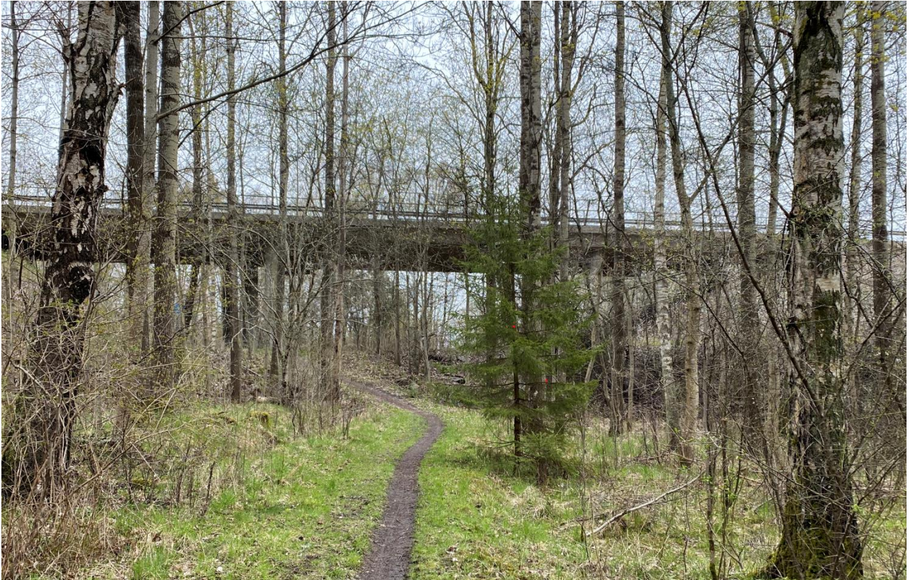
Figur 5. Stigen från Älvåsvägen till GC-vägen Rälstrampen där denna korsar under E 45
