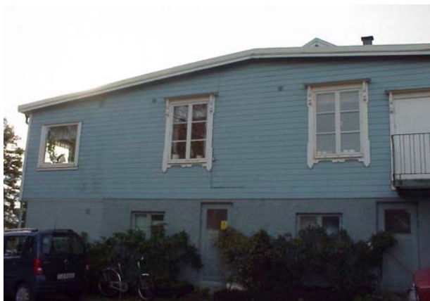
Norrfasad: flyttade originalfönster
