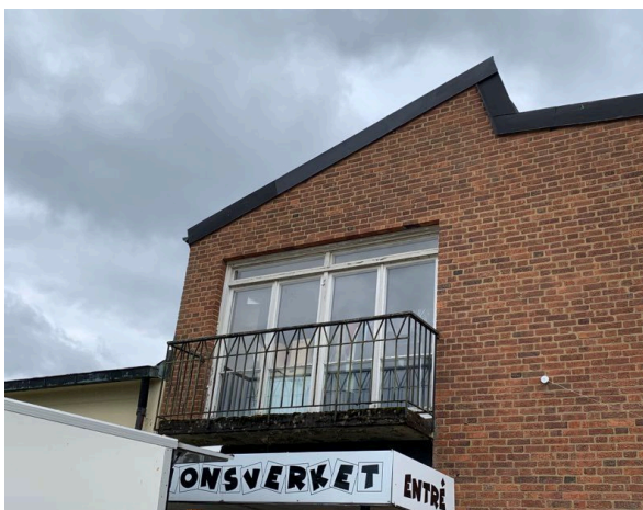
Bild 40 Befintlig byggnad, detaljer så som smidesräcke och markerad takfot.
