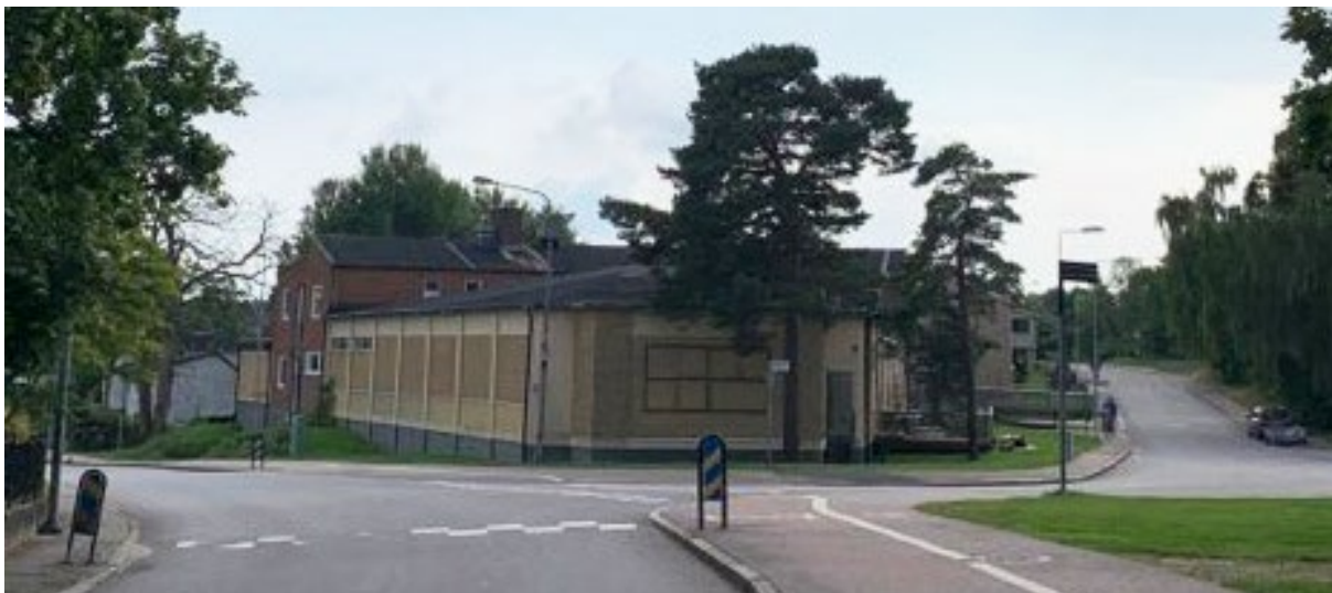
Bild 27 Befintlig byggnad i korsningen mellan Göteborgsvägen och Nysätersvägen. Till höger syns de två tallarna på Gullriset 2.
