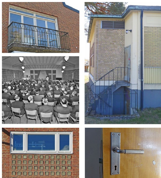
Bild 35. Exempel på kulturhistoriskt värdefulla byggnadsdelar. Från kulturmiljöutredningen.
