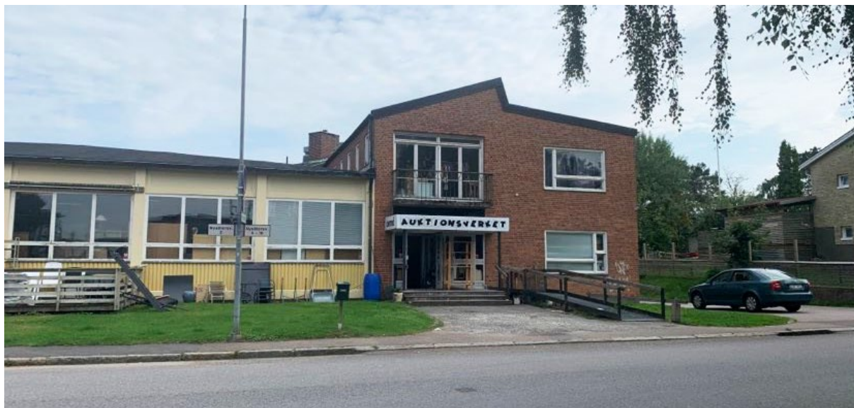
Bild 14 Befintlig byggnad, fasad mot Nysätersvägen.
