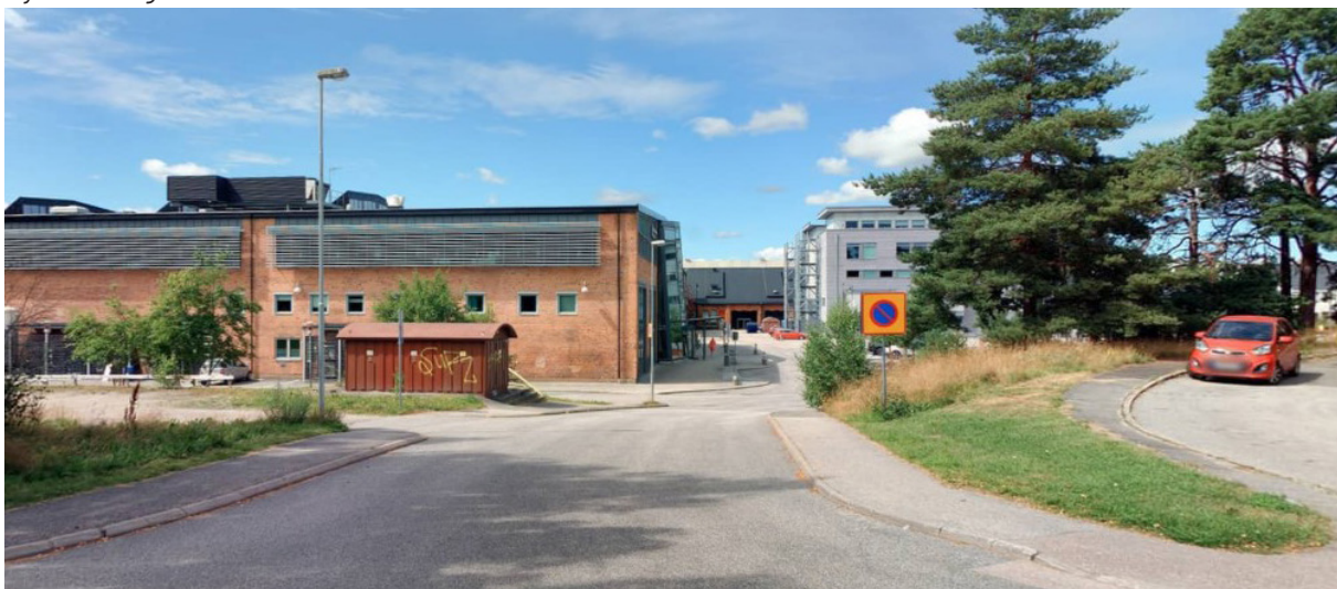
Gullrisgatan utgör en entré till Innovatumområdet med karaktär av en bakgata.
