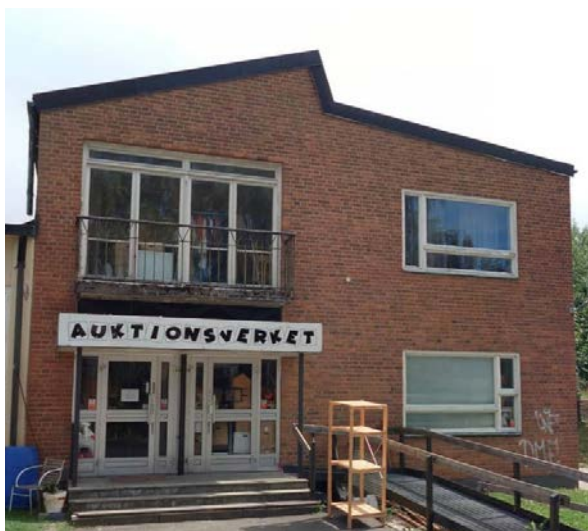
Befintlig byggnad på Gullriset 2. Entré mot Nysätersvägen.
