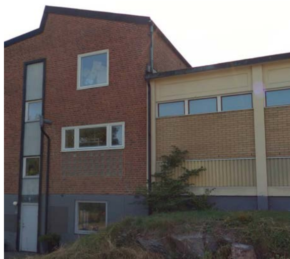
Befintlig byggnad på Gullriset 2. Fasad mot Göteborgsvägen.
