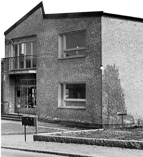
Befintlig byggnad har en tydligt markerad takfot i svart plåt. Bild från Innovatums bildarkiv.
