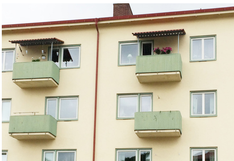
Till vänster: Balkonger mot Drottninggatan med småprofilerad sinuskorrugerad plåt och rundade hörn Fönster ligger i liv med fasad. Tvålufts-fönster. Tidstypisk indelning och proportioner.
