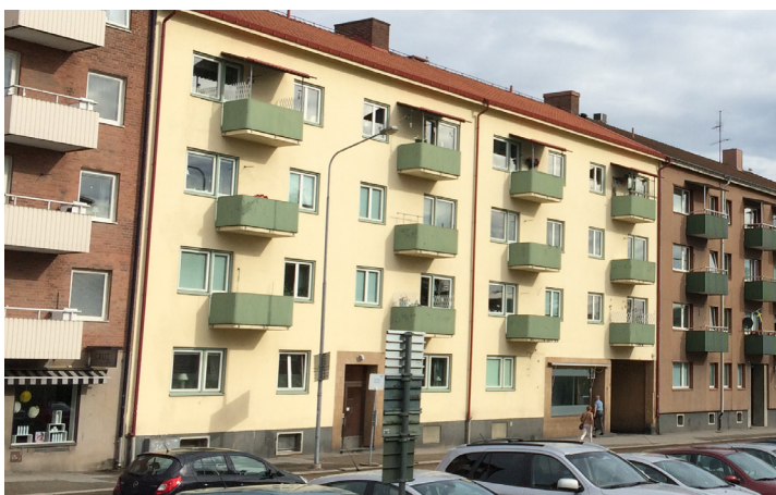
Fastigheten på Gullön 8 som är kulturhistoriskt värdefull.
