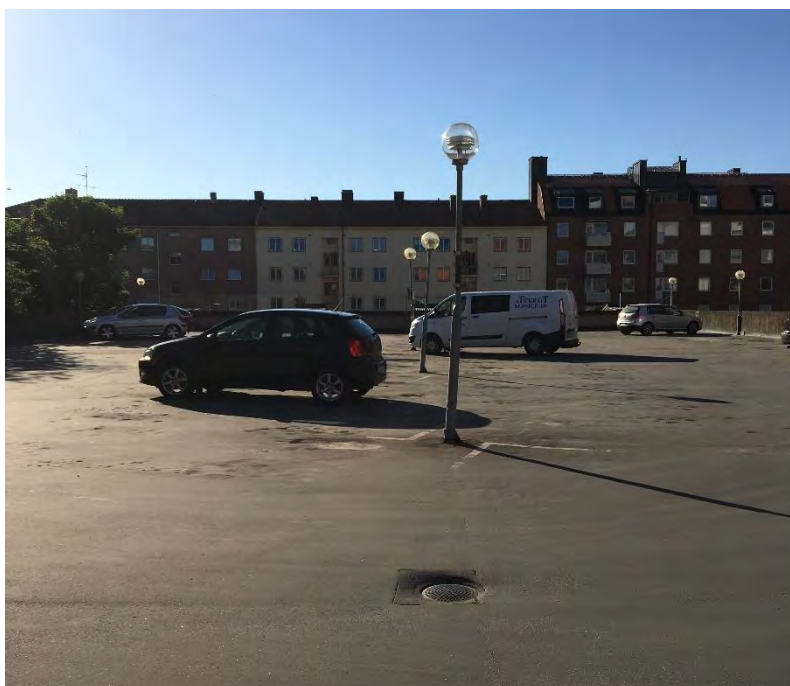
Figur 5 Brunnar placerade i mitten av asfaltsparkeringen för att samla upp dagvatten.
