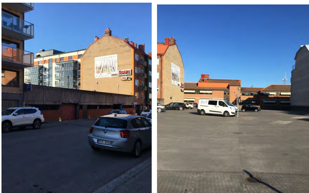
Figur 4 Bild till vänster visar garaget som asfaltsparkeringen är byggd ovanpå. Bilden till höger visar den upphöjda asfaltsparkeringen.
