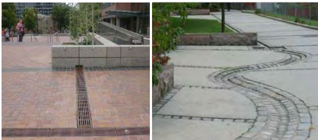
Figur 19 Exempel på dagvattenrännor (Uppsala Vatten 2017). Försees rännan med galler blir framkomligheten bättre.
