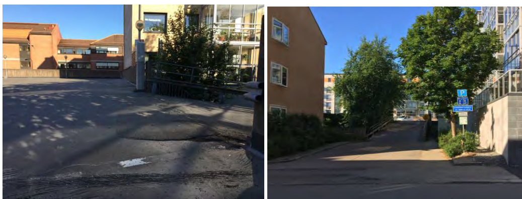
Figur 6 Uppfarten till asfaltsparkeringen är något förhöjd vilket troligen stoppar en del av ytvavrinningen.
