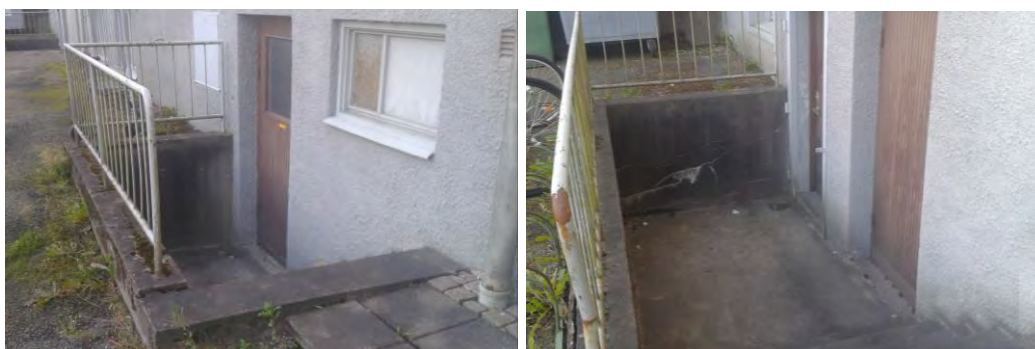
Figur 12 Trappnedgångar inom gården som alla är försedda med gallerbrunnar.
