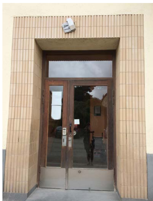
Entréparti med dörr av ek och glaspartier omramat av fasadklinker.
