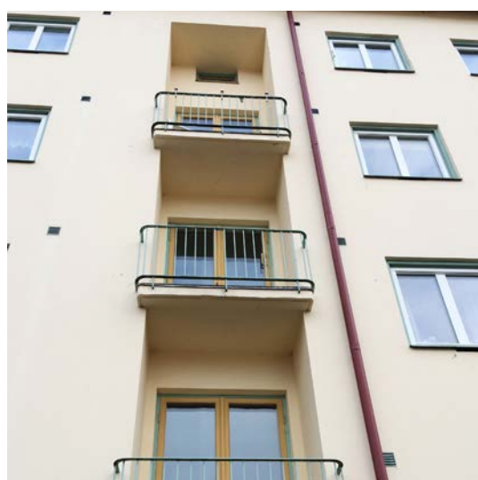
Till vänster: Balkonger mot Drottninggatan med småprofilerad sinuskorrugerad plåt och rundade hörn. Fönster ligger i liv med fasad. Tvåluftsfönster. Tidstypisk indelning och proportioner.
