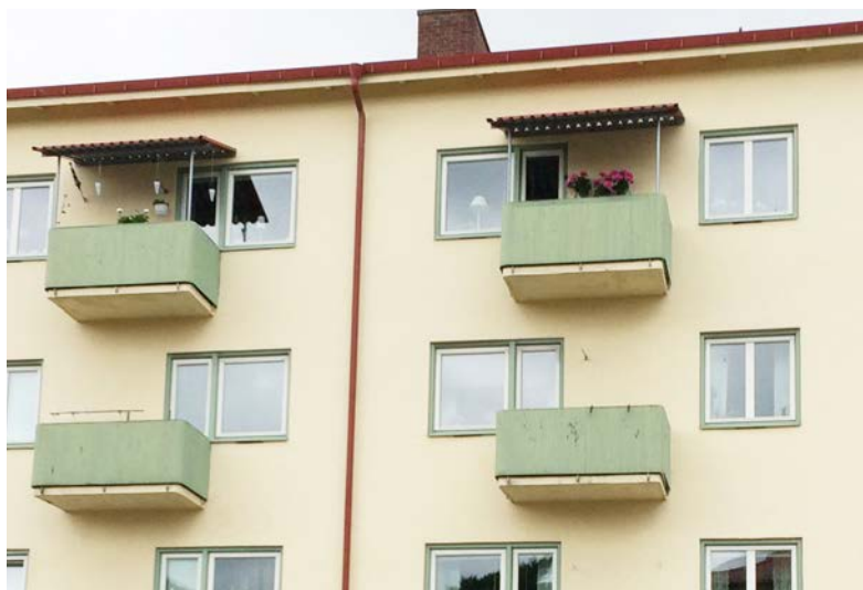
Till vänster: Balkonger mot Drottninggatan med småprofilerad sinuskorrugerad plåt och rundade hörn Fönster ligger i liv med fasad. Tvåluftsfönster. Tidstypisk indelning och proportioner.
