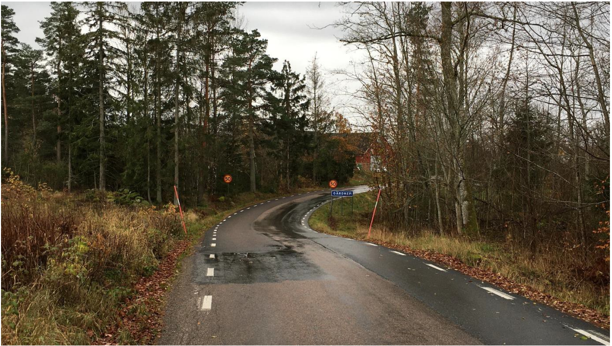
Bild som visar sikt söderut från föreslagen passage över Hullsjövägen. Vegetation på vägens högra sida tas bort för att skapa ytterligare sikt så att ladugårdsgaveln blir helt synlig. Då uppnås sikt på 170 meter.
