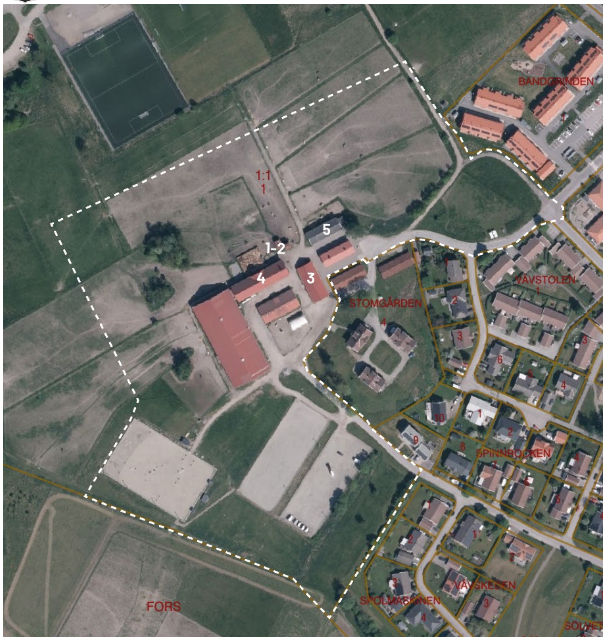
Bilden visar de fem ekonomibyggnaderna som bedöms ha högt allmänt bebyggelsevärde.
