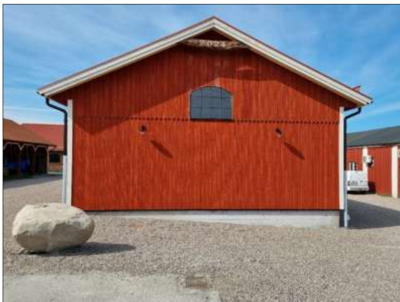
Figur 6. Foto över nybyggt skötselhus inom planområdet. Foto: Norconsult
