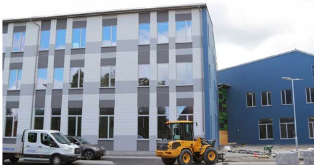
Bild 5. Nya Sylteskolan under byggnation.
