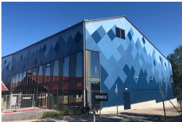
Bild 6. Nya idrottshallen på Sylteskolan.
