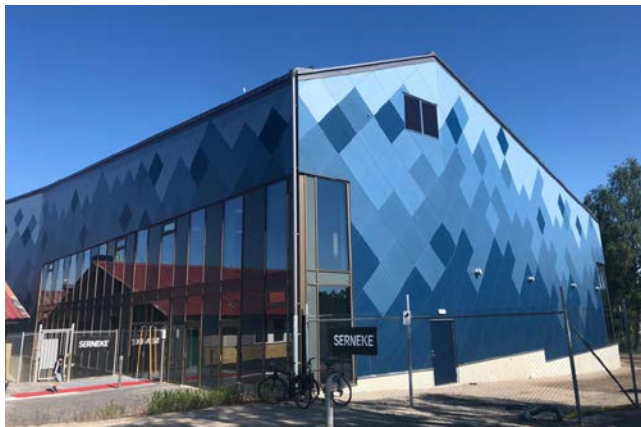
Bild 7. Nya idrottshallen på Sylteskolan.
