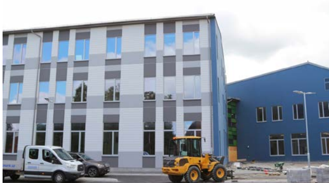
Bild 6. Nya Sylteskolan under byggnation.
