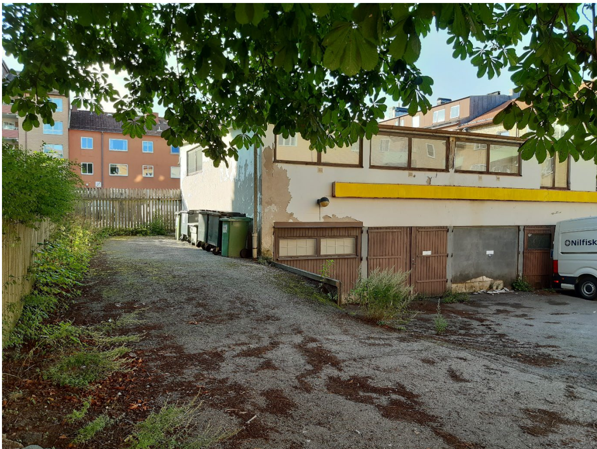
Bild 18. är tagen i gränsen mellan Eken 9 och 8. I bilden syns marknivåskillnaderna inom planområdet, inom Eken 9.
