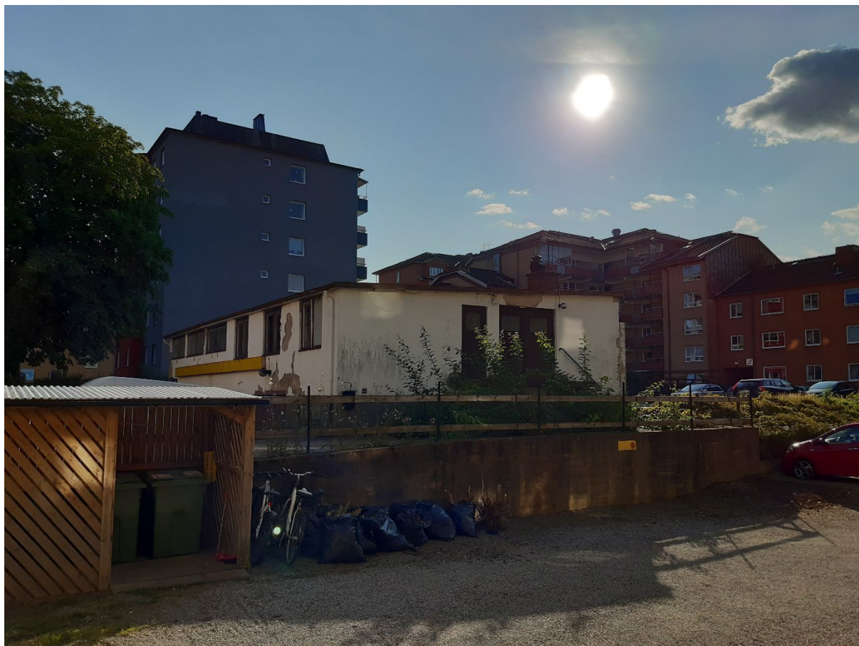
Bild 15. är tagen från fastighet Eken 2 och visar på höjdskillnaderna i planområdet. I bilden syns även den befintliga garage och verkstadsbyggnaden inom Eken 9, samt punkthuset inom Eken 6.
