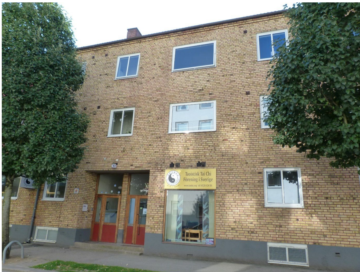
Bild 14. Visar entrén från gatan på det befintliga bostadshuset på Eken 4.
