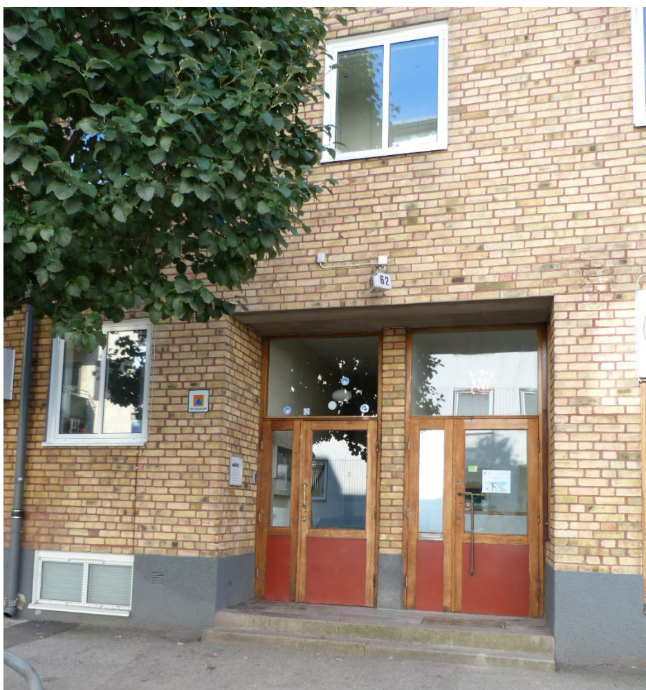
Bild 13. Visar entrén från gatan på det befintliga bostadshuset på Eken 4.
