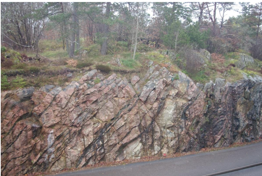
Figur 4 Dominanta sprickor med orientering 225^{\circ}/50^{\circ} gynnsamma ur stabilitetssynpunkt.
