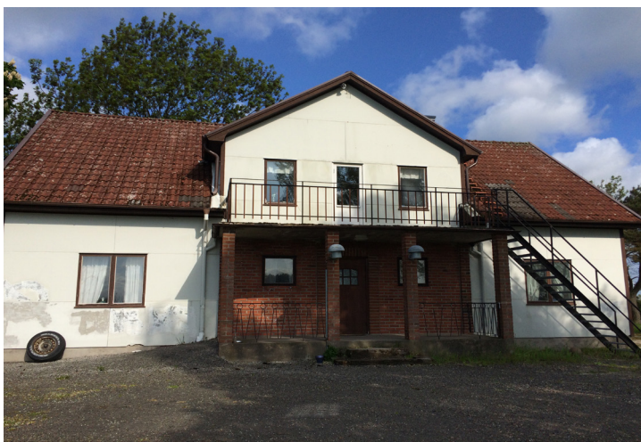
Befintlig mangårdsbyggnad tillhörande f.d. Kåtene gård.
