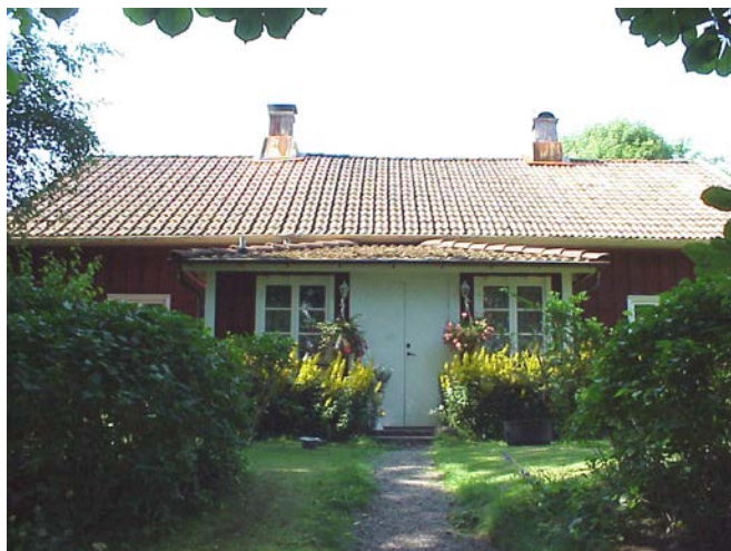
Boningshus, ingång med inbyggd veranda.
