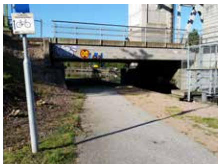
Tunnel vid järnvägsbrons östra brofäste
