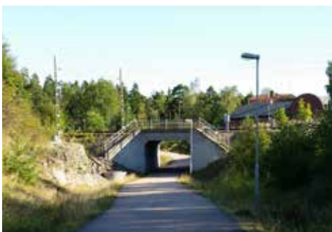
Tunnel söder om Stridsberg & Biörck
