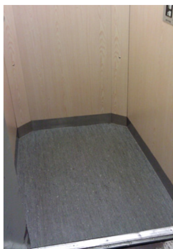
Hissen på Stensmejdjan fyller en mycket viktig funktion, men är inte tillräckligt stor för att rymma gånghjälpmedel utan problem.
