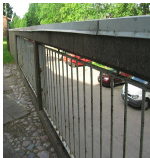
Muren som skyddar bostadsområdet från Lantmannavägen är delvis sönderfallen och består av rostet armeringsjärn. En trevligare mur som kopplar samman bostadsområdet med livet utanför eftersöks.
