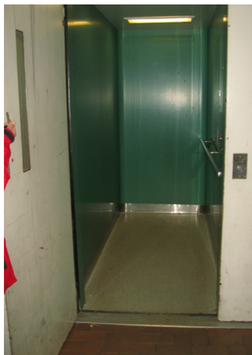
Det är positivt att fastigheterna har hiss, men hissens storlek är väl liten för att rymma gånghjälpmedel utan problem.
