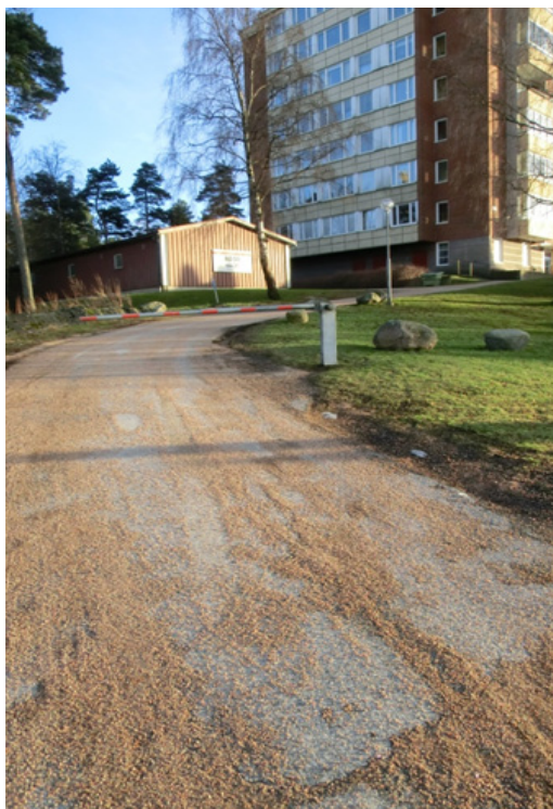
Det är svårt att ta sig både uppför och nedför den branta backen.
