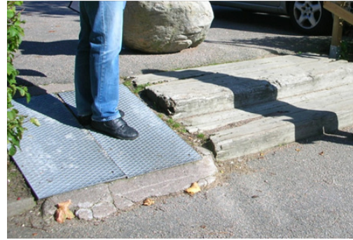
Den lösning som installerats på ett ställe snarare ställde till det än underlättade för den rullstolsburne.
