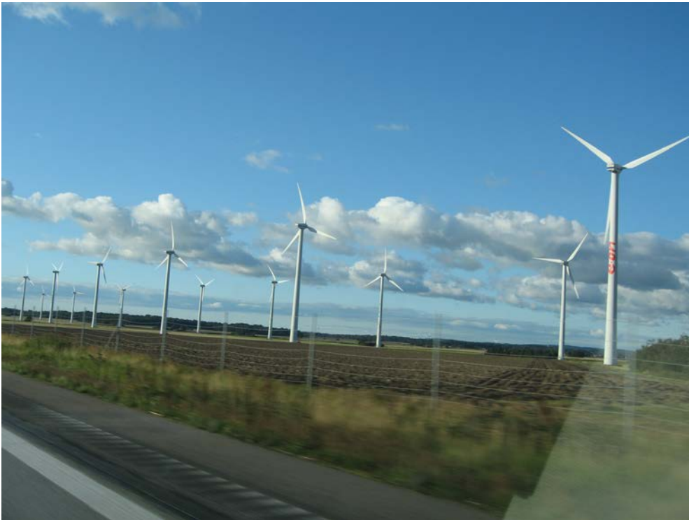
Vindkraftverk längs en väg på åkermark. Vid denna placering blir verken helt exponerade i landskapet Foto: Susanne Nilsson
