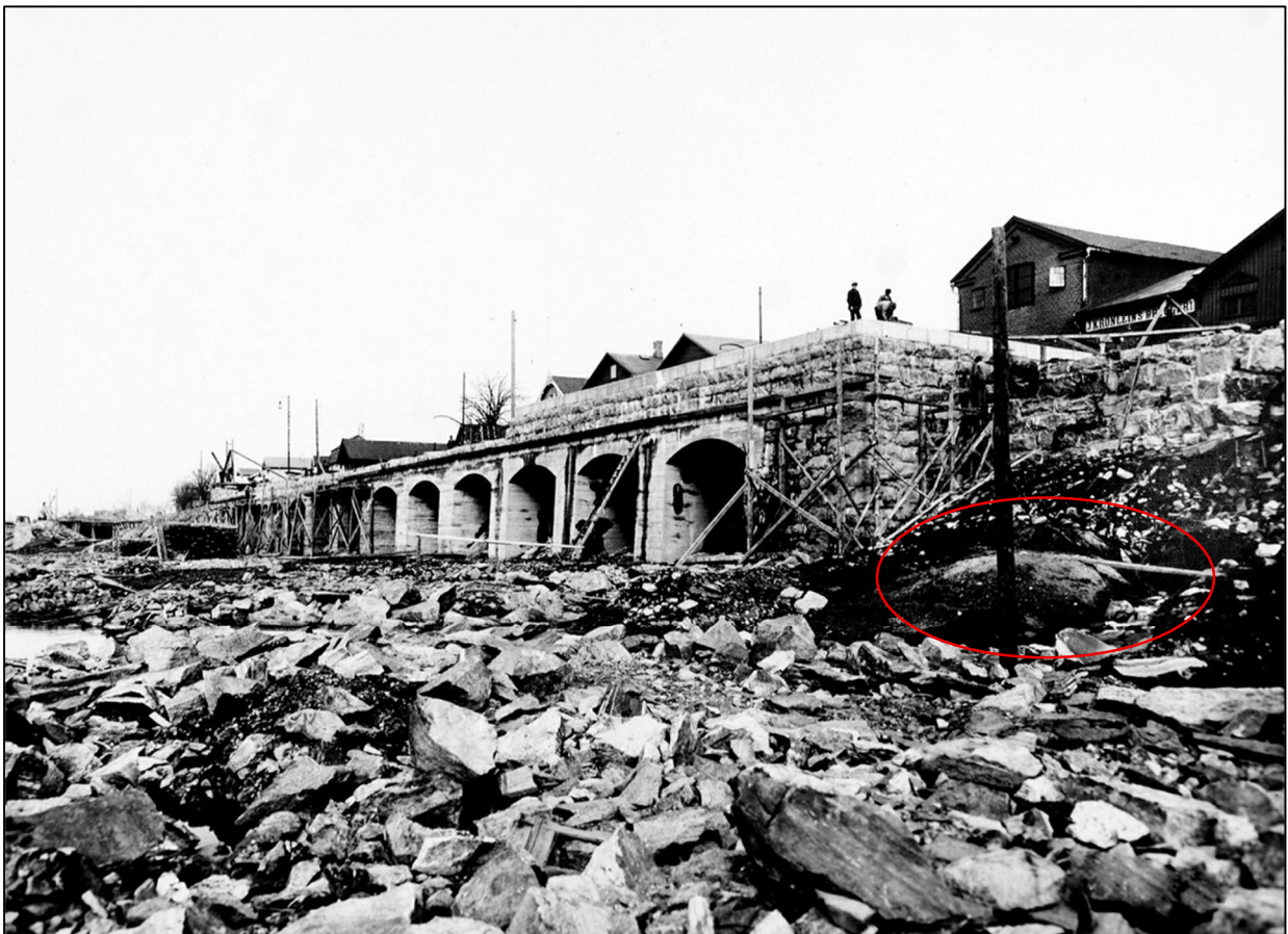
Figur 11. Historiskt fotografi från 1915, vy mot nordost. Röd markering visar förmodat berg i dagen i anslutning till kajkonstruktionen. Bild tillhandahållen av beställaren.
