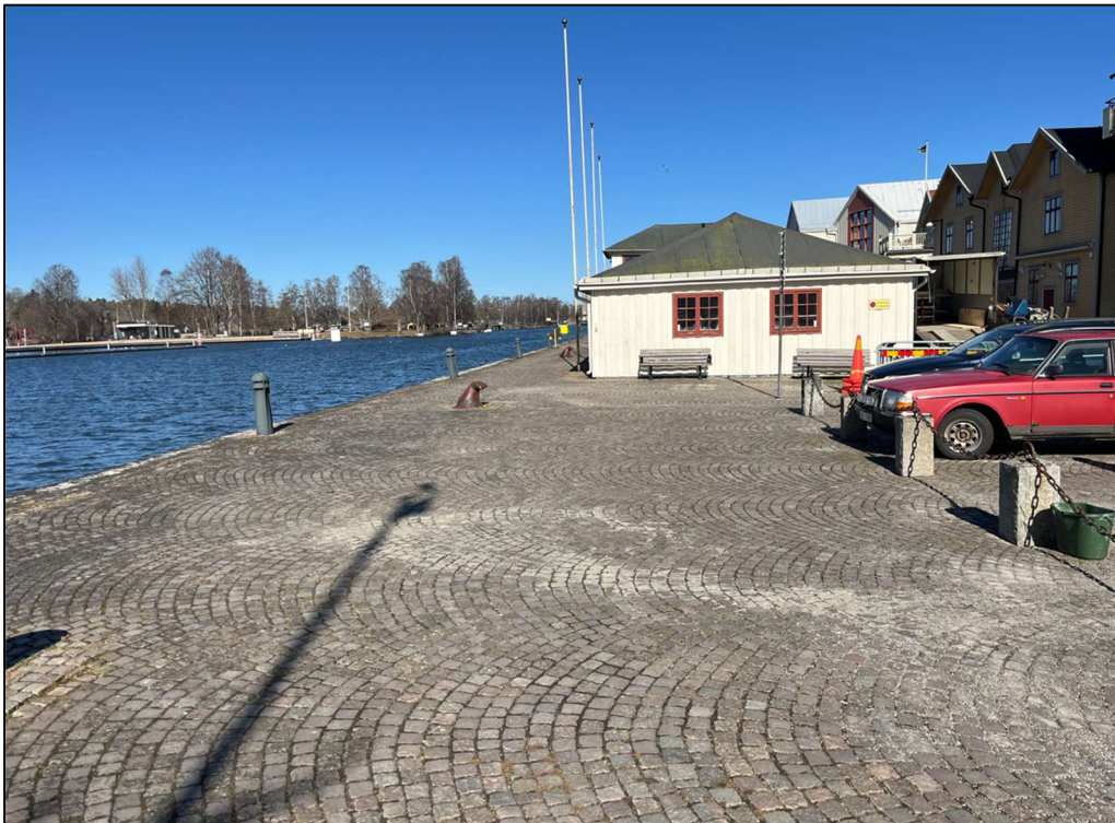
Figur 4. Överblicksbild på undersökt område vy mot nordöst. Källa: Geosond, daterad 2026-03-28.
