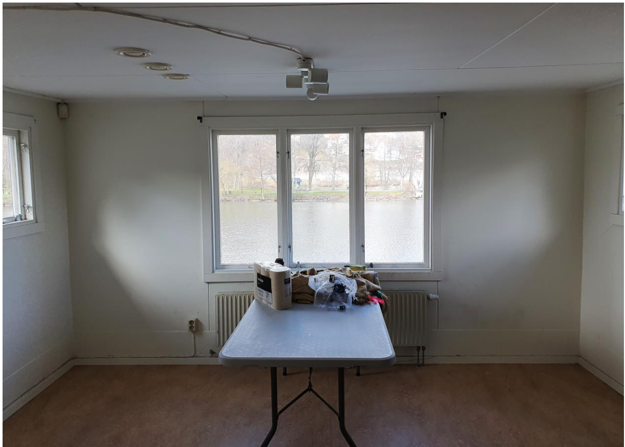
Rum på övervåningen med plastmatta, skivmaterial på väggar och i tak samt släta foder. All inredning är senare tillkommen.
