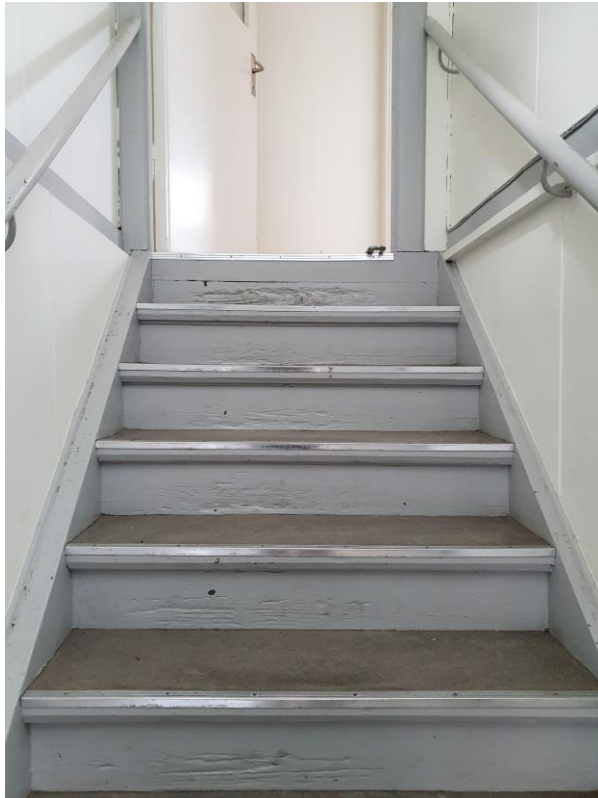
Äldre trappa i trä mot övervåningen.
