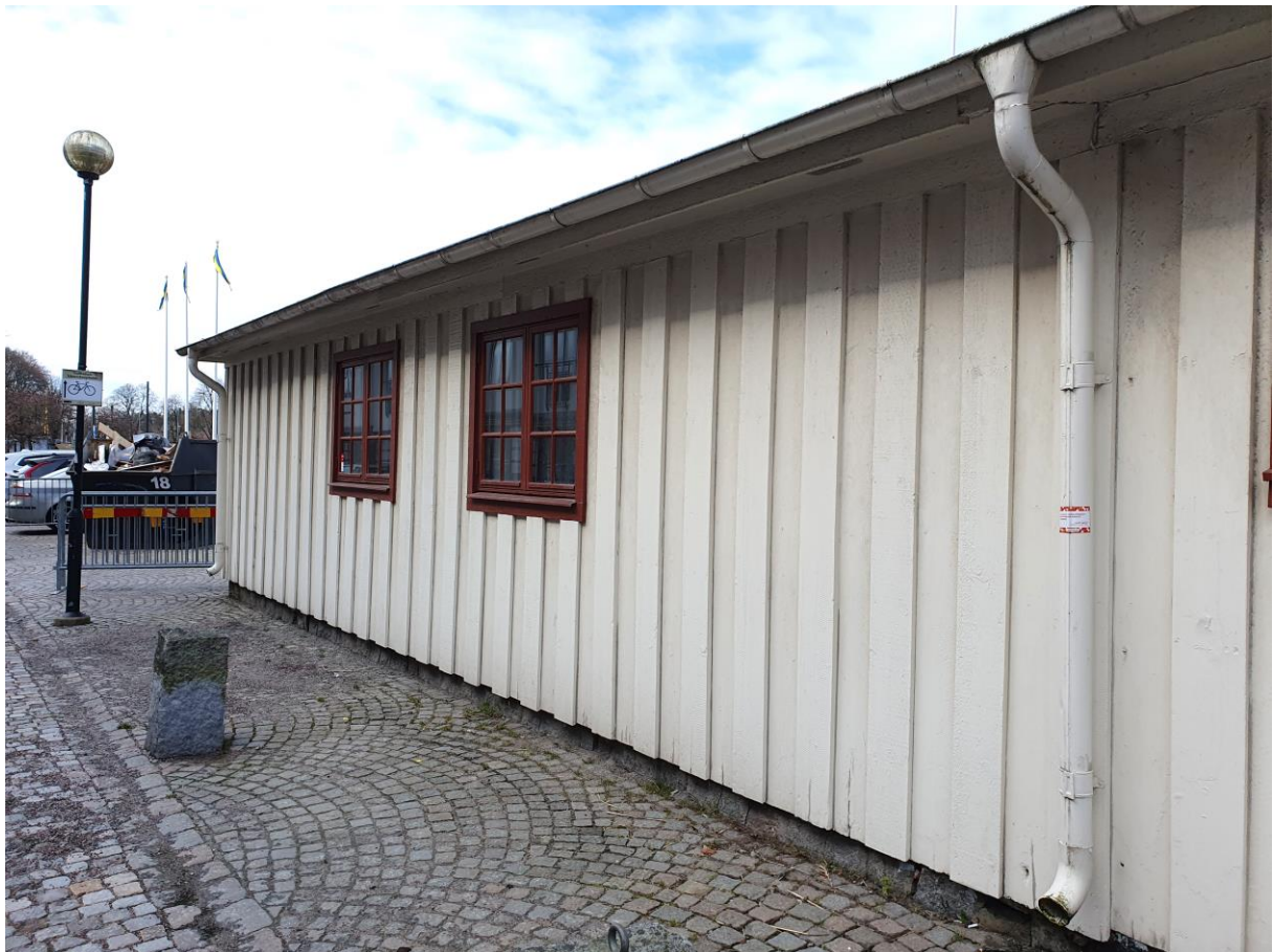
Den förlängda delen av byggnaden som tillkom 1960 och kompletterades med spröjsade fönster 1997.
