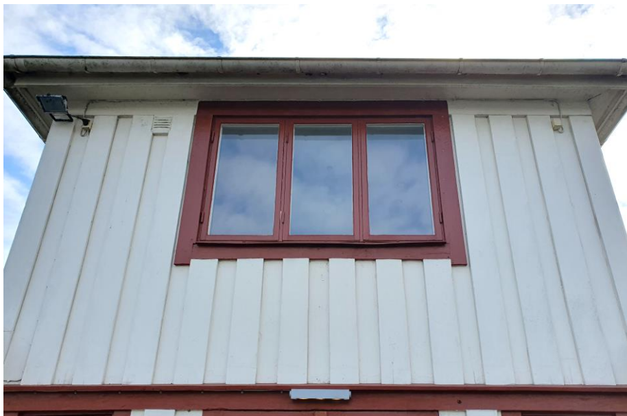
Övervåningen inrymde ursprungligen hamnkontoret. Fönstret är numera utbytt.
