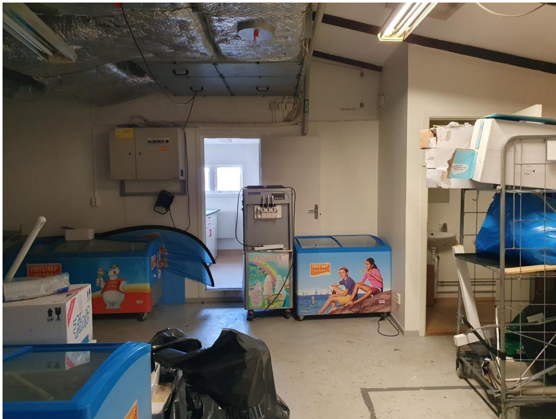
Kök, wc och lager i den ursprungliga delen. Mattor, skivmaterial och snickerier tillkomna i senare tid.
