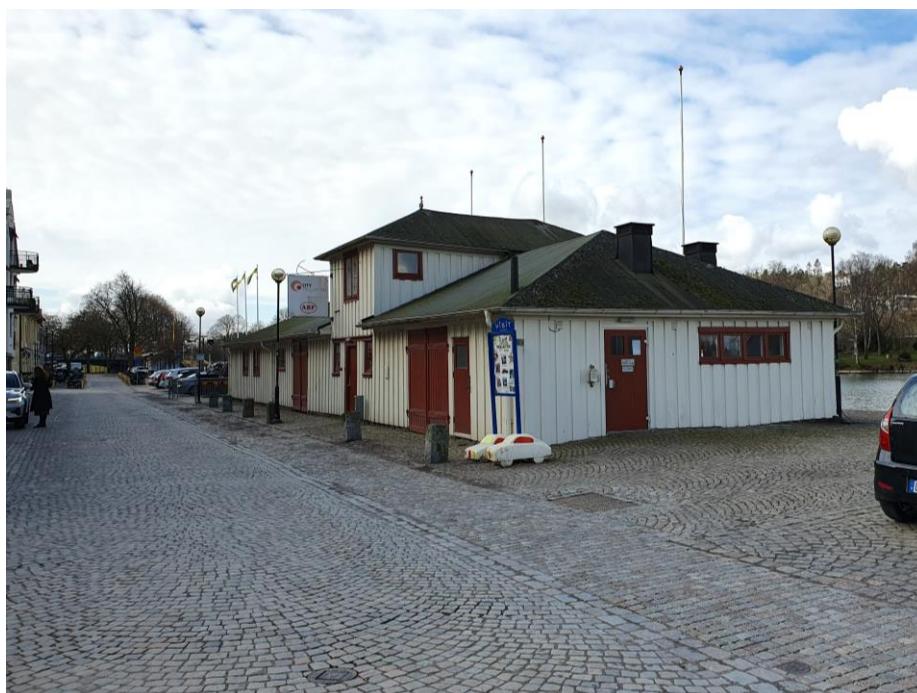
Den huvudsakliga byggnadskroppen i en våning bryts av en mindre andra våning med tvärställt valmat tak.
