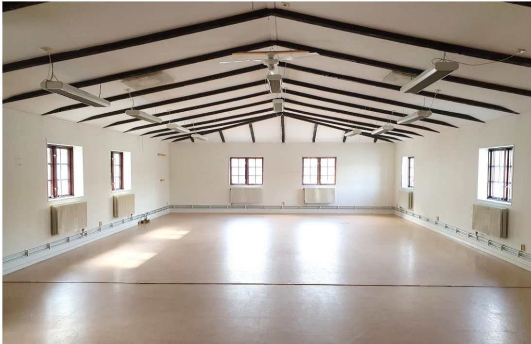
Öppet rum i den tillbyggda delen. Matta, skivmaterial och snickerier tillkomna i senare tid.
