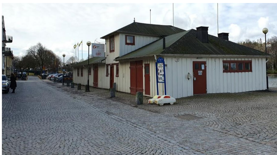
Bild 10. Vy från norr över befintlig byggnad.
