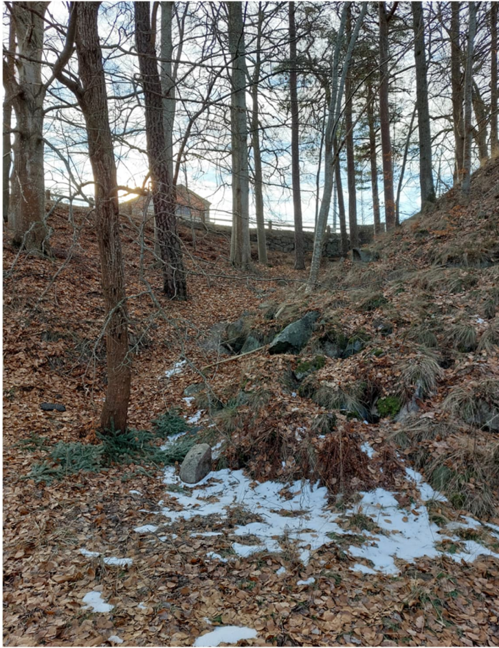
Figur 12. Sprängstensfyllning i slänt nedanför Åkersbergsvägen (foto nr 3). Vy mot sydost.
