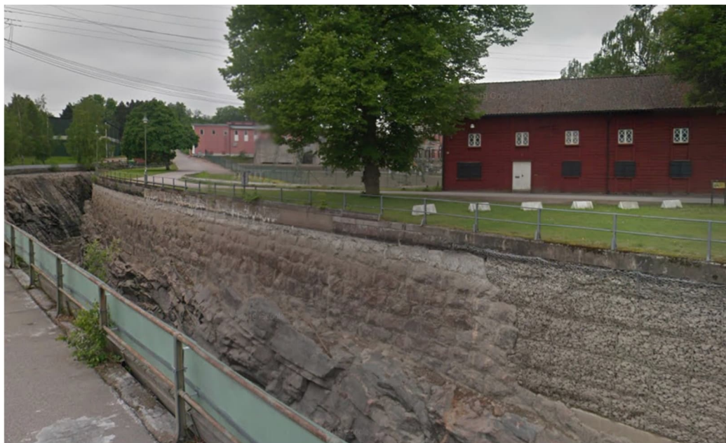
Figur 7. Stödmur vid Kyrkbrovägen längs med gamla Bergkanalen. Vy mot sydväst. (Källa: Google maps, bildinsamling juni 2011)
