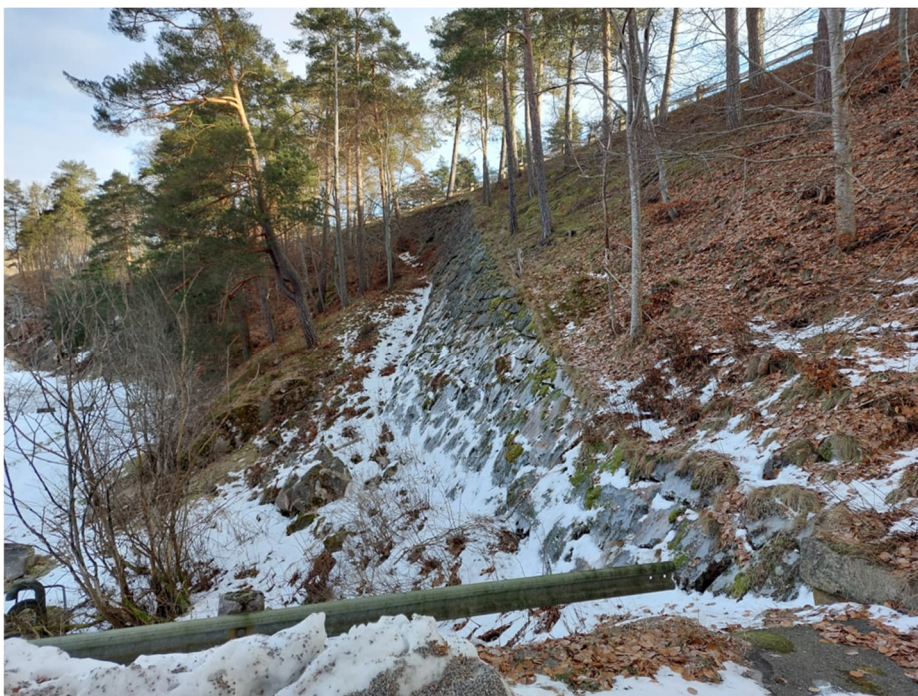
Figur 11. Fyllning ovan berg samt stödmur i slänt nedanför Åkersbergsvägen (Foto nr 2). Vy mot nordost.
