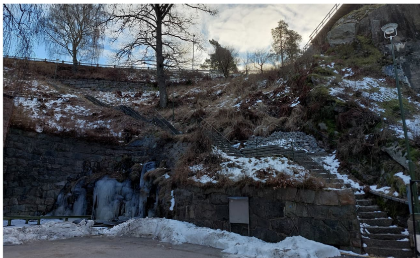
Figur 15. Slänt mot Olidans kraftverk (foto nr 4). Vy mot sydost.
