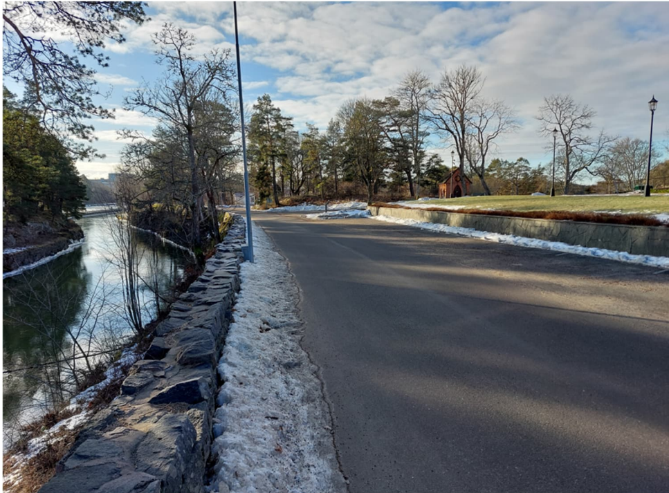
Figur 16. Kyrkbrovägen i höjd med Trollhättans kyrka (foto nr 5). Vy mot söder. Vägen ligger här på ett tunt lager fyllning ovan berg.
