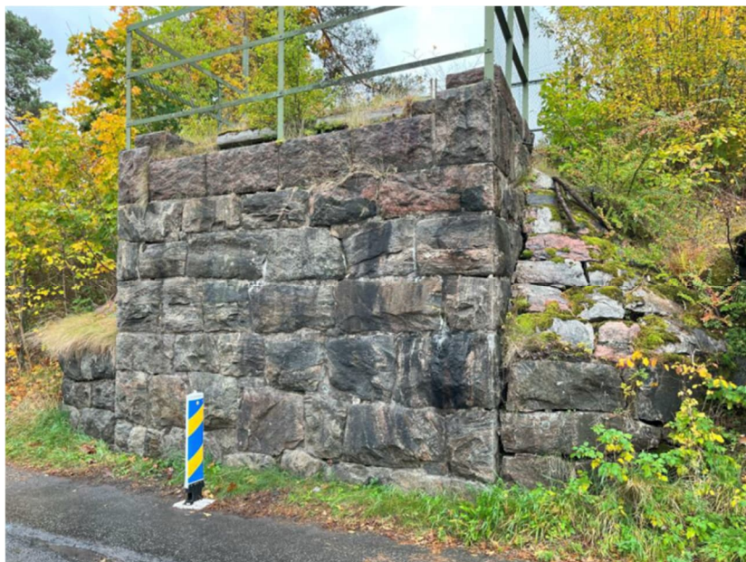
Figur 6. Brostöd från tidigare järnvägsbro som korsat Åkersbergsvägen
