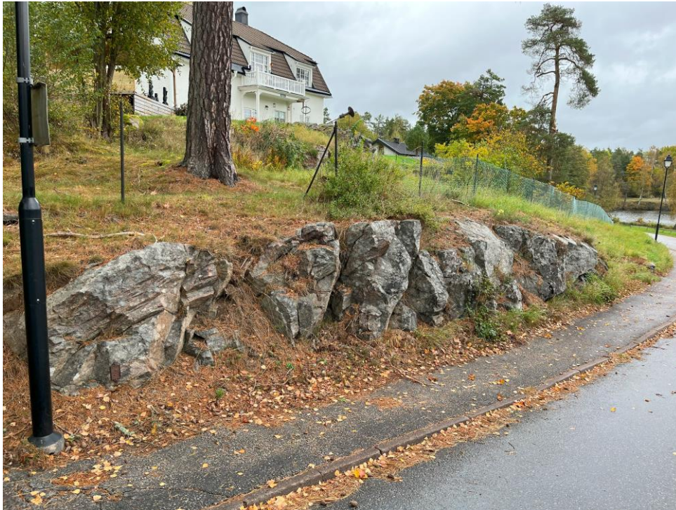
Figur 10. Bergskärning västra sidan.
