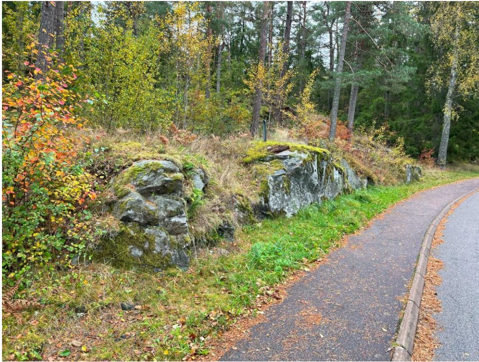
Figur 8. Bergskärning västra sidan
