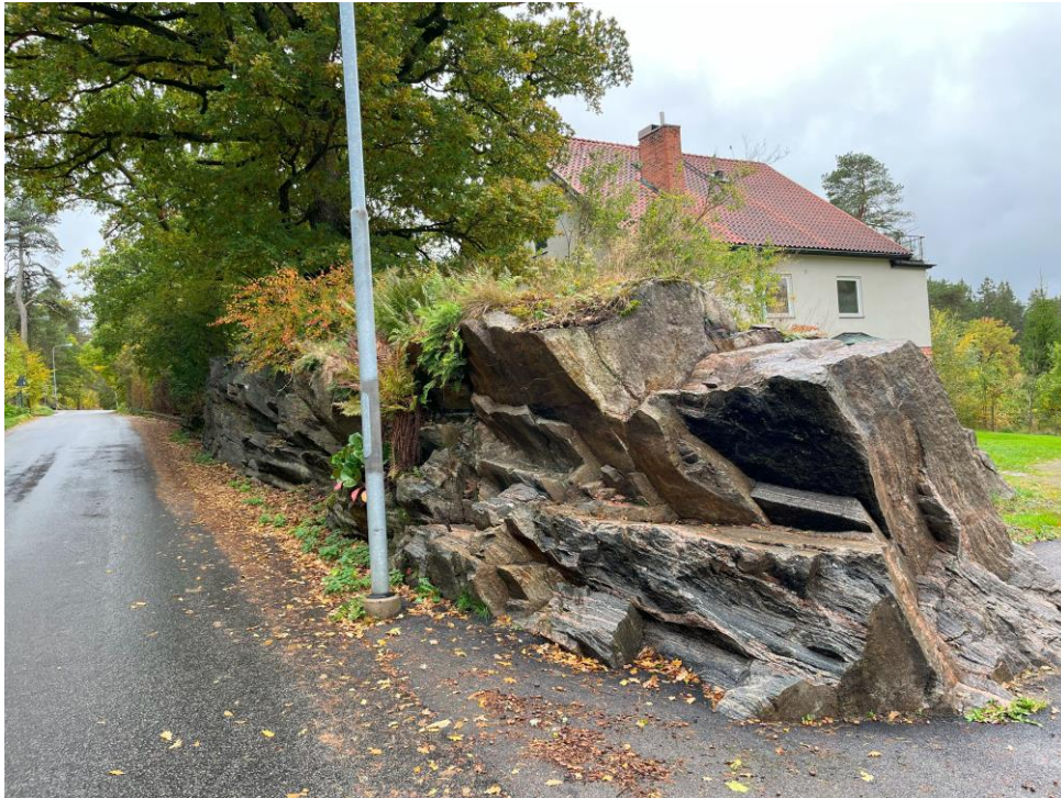
Figur 2. Den västra bergskärningen som visar den branta stupningen av berget åt väster.
