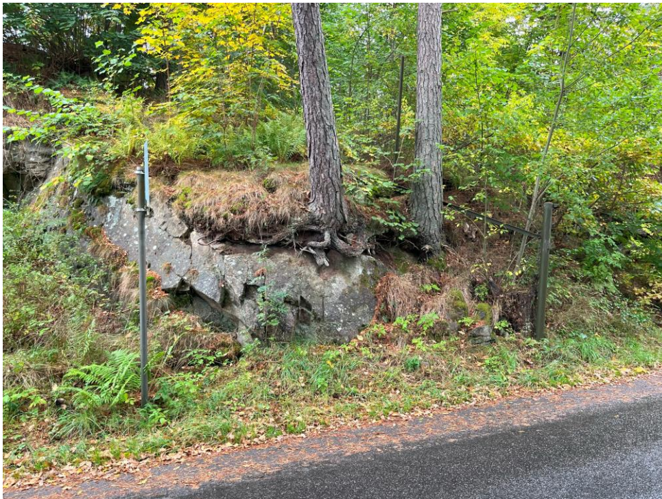
Figur 4. Tall som står på bergskanten och behövs tas ned,
