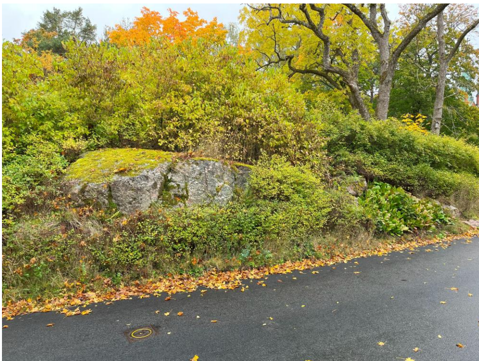
Figur 19. Låg bergskärning västra sidan.
