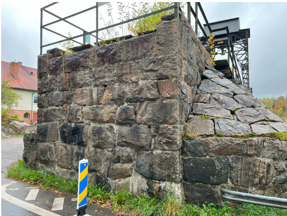
Figur 5. Stenmuren på västra sidan
