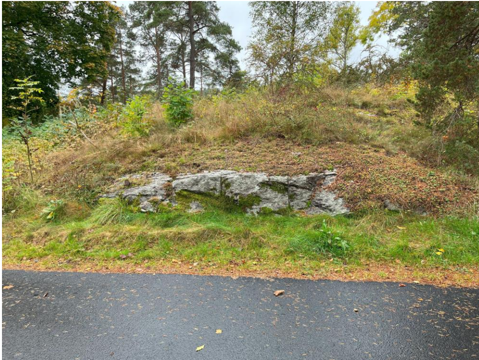
Figur 18. Låg bergskärning västra sidan.
