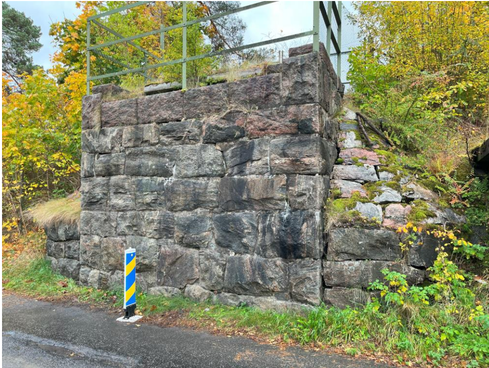
Figur 6. Stenmuren på östra sidan.
