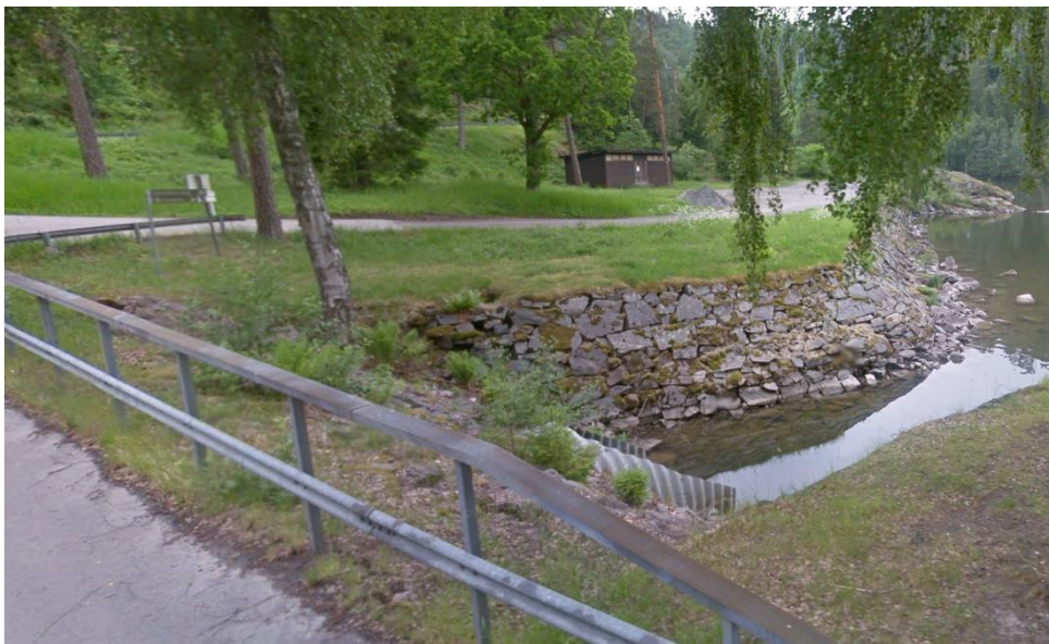
Figur 12. Nedre delen av delsträcka 3 med erosionsskyddad slänt mot Göta älv. I förgrunden syns utloppskanalen från Nohabs gamla turbinprovstation. (Bild från Google maps)
